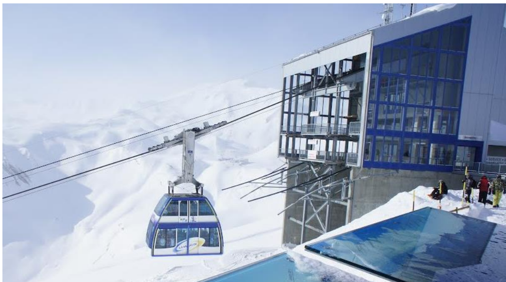
Obr. 6 - Dvoupatrová kabina – pohled na horní stanici [7]
