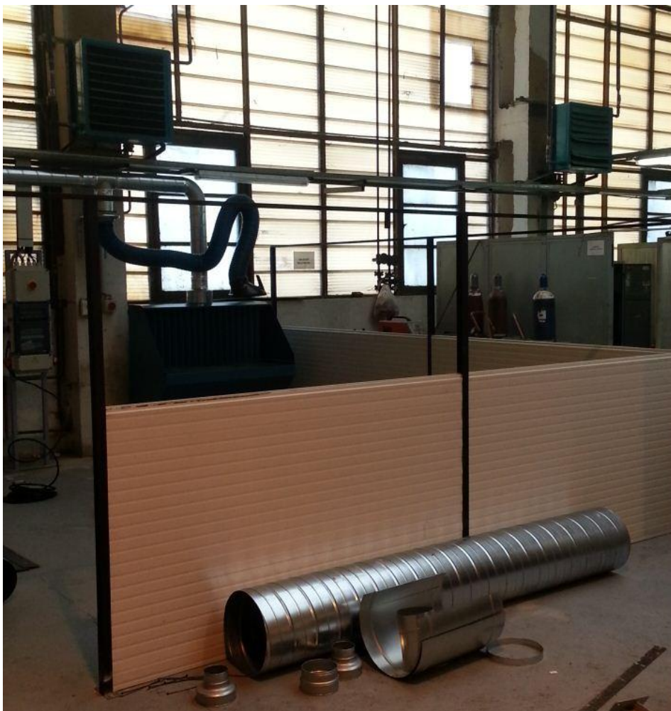
Obrázek č.11 - Průběh výstavby
