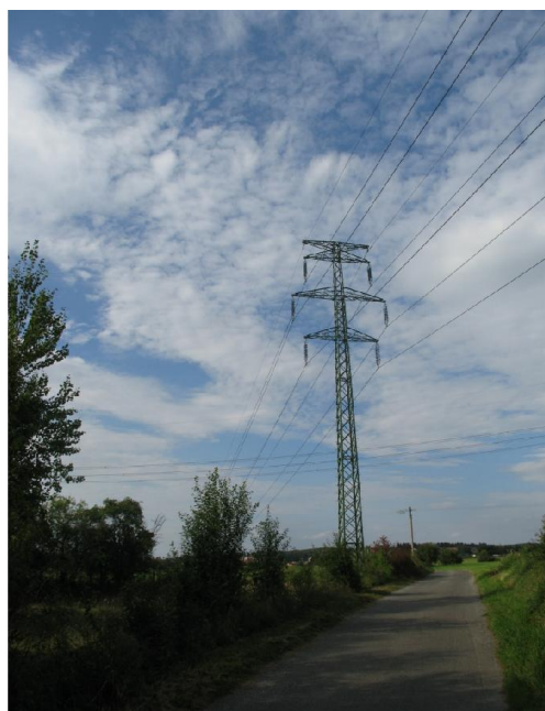
Obr. 2 Venkovní vedení 110 kV s dvojitým zemnicím lanem. [8]
