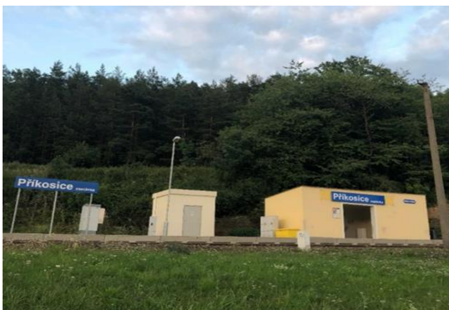
Obrázek 5: Železniční stanice ve venkovské obci
