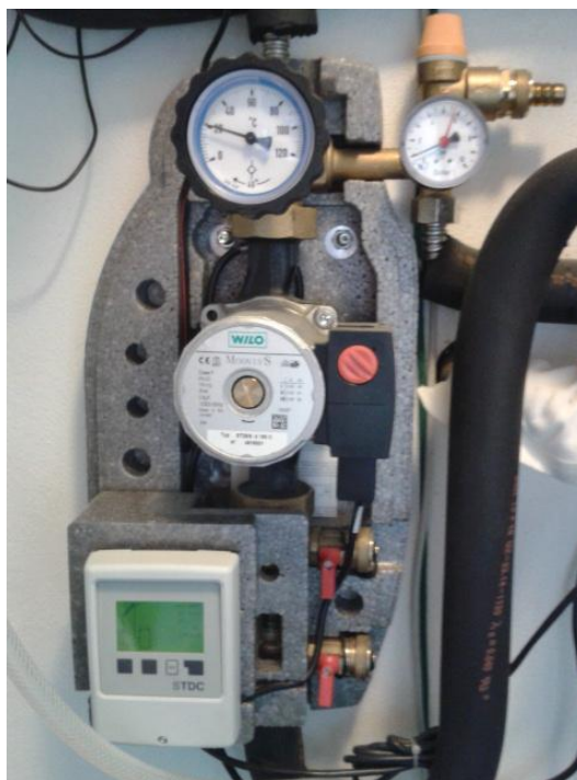
Obrázek č. 14: Jednotrubková čerpadlová skupina Solar 10.
