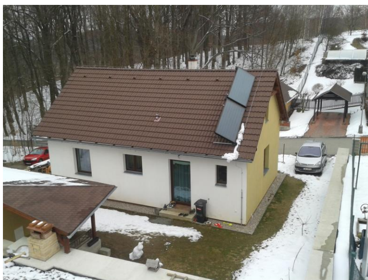
Obrázek č. 13: Solární kolektory na rodinném domku v Chotěboři.
