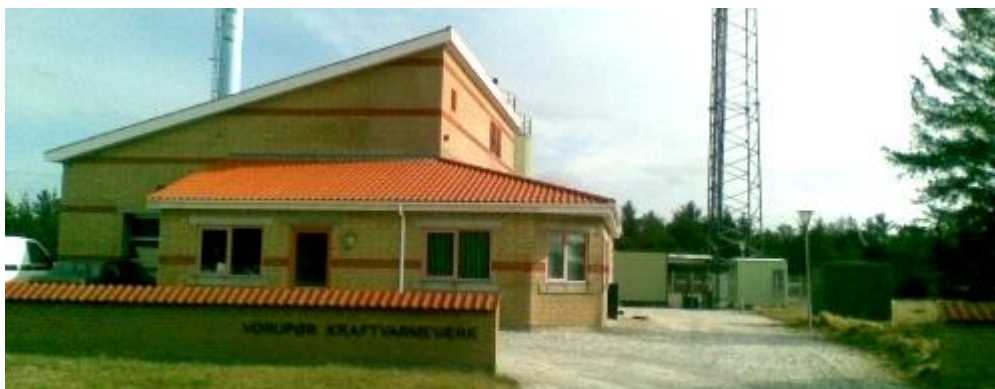
Obr. 4.16 Pohled na budovu kogeneračního provozu
