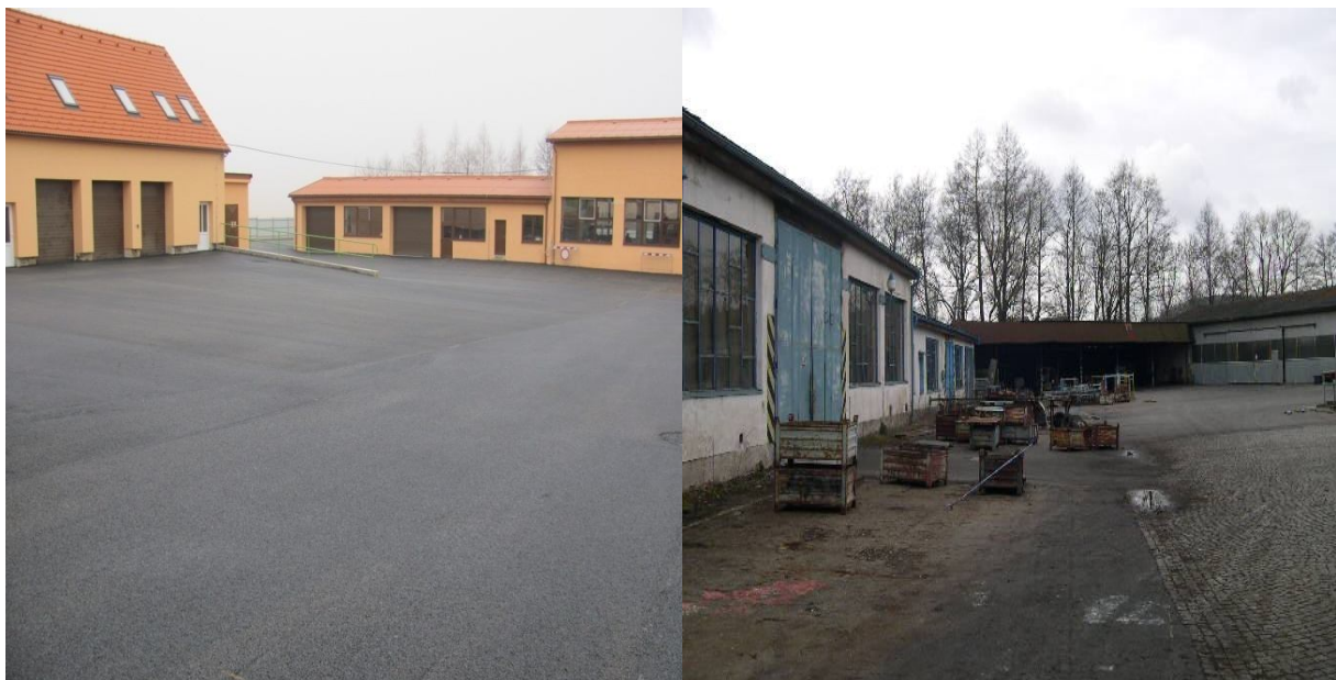
Obr. 1 Rekonstrukce výrobního areálu ve Vlachově Březí [Zdroj: 18]
