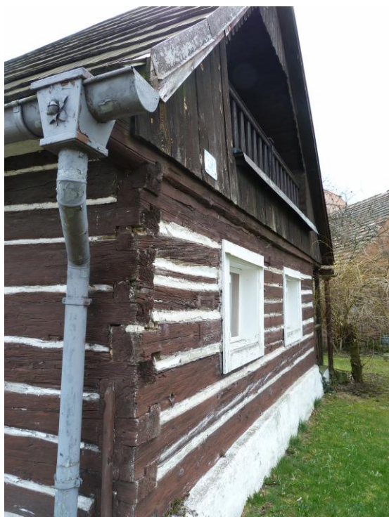
Obr. 12: Potvorov, roubená konstrukce č.e. 1 (foto Pavuková)
