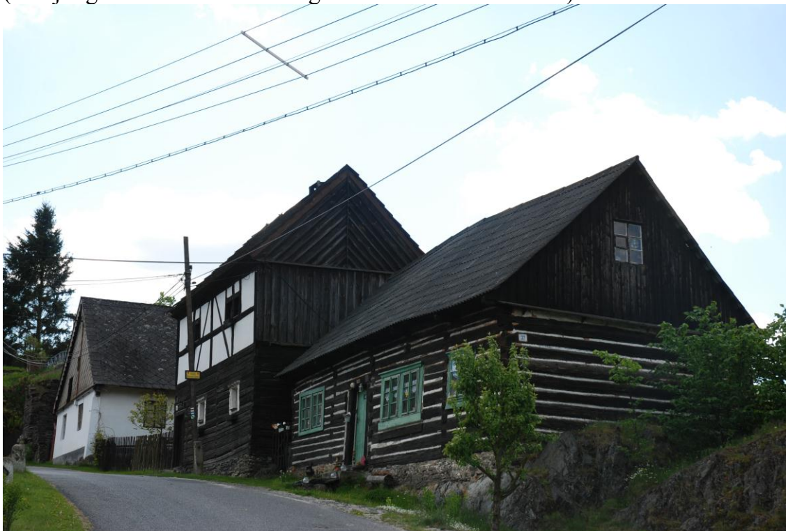
Obr. 15: Rabštejn nad Střelou, kombinace roubené a hrázděné konstrukce č.e. 76 (zdroj digitální archiv Muzea a galerie severního Plzeňska)
