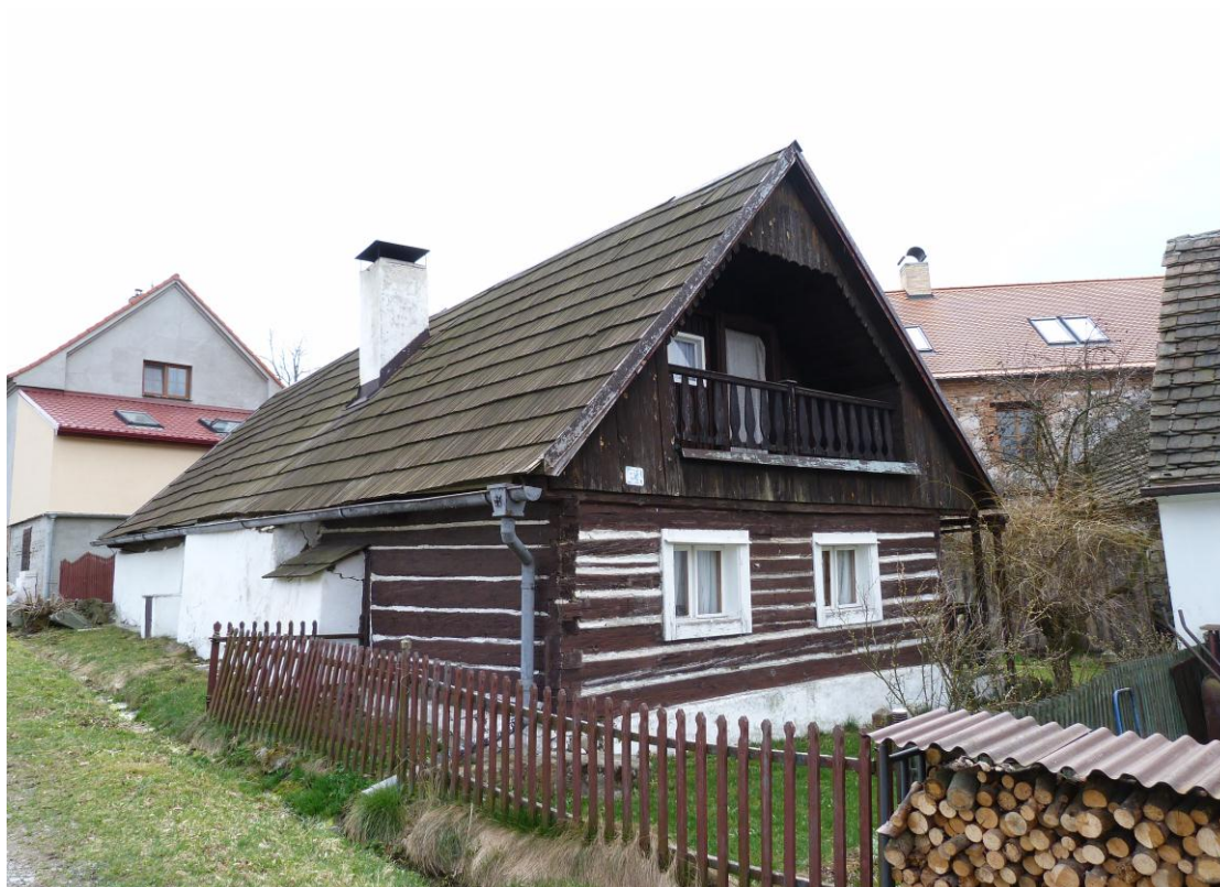
Obr. 11: Potvorov, roubená konstrukce č.e. 1 (foto Pavuková)
