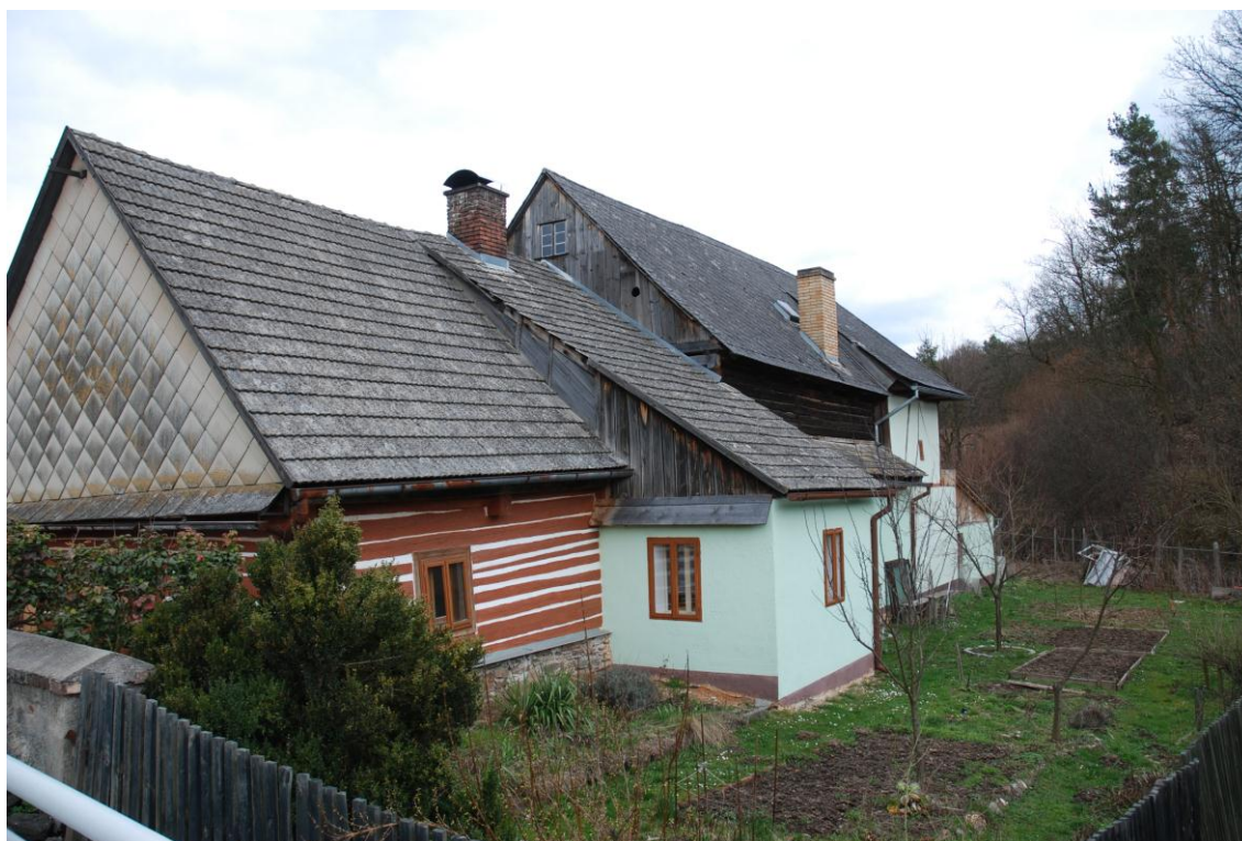
Obr. 10: Rybnice, roubená konstrukce (foto Pavuková)
