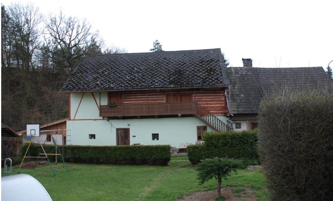
Obr. 9: Rybnice, roubená konstrukce domu (foto Pavuková)
