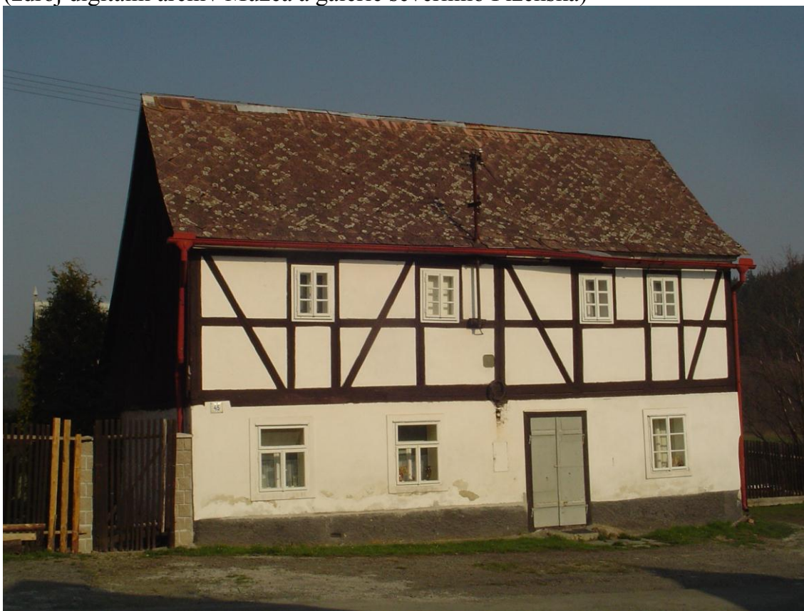
Obr. 14: Rabštejn nad Střelou, kombinace roubené a hrázděné konstrukce č.p. 45 (zdroj digitální archiv Muzea a galerie severního Plzeňska)
