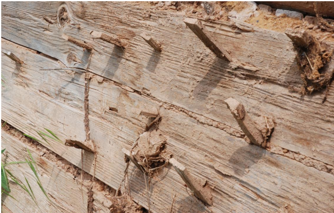
Obr. 6: Manětín, roubená konstrukce u domu č. p. 70 – detail kolíků pro přichycení mazanice (zdroj digitální archiv Muzea a galerie severního Plzeňska)
