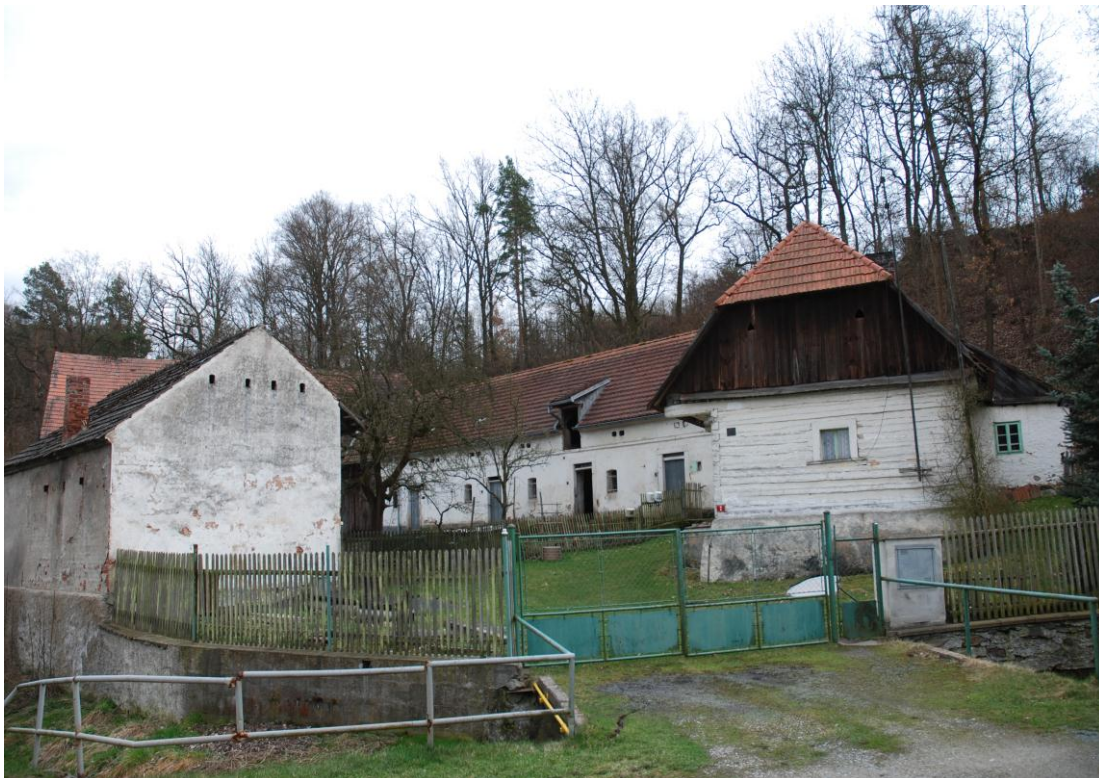
Obr. 7: Rybnice, roubená konstrukce domu č. p. 2 (foto Pavuková)
