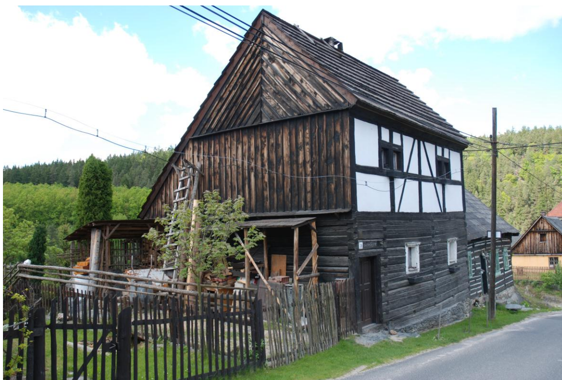
Obr. 13: Rabštejn nad Sřelou, kombinace roubené a hrážděné konstrukce č.p. 38 (zdroj digitální archiv Muzea a galerie severního Plzeňska)
