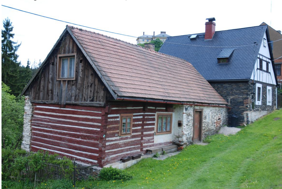
Obr. 16: Rabštejn nad Střelou, roubené konstrukce č.e. 61 (zdroj digitální archiv Muzea a galerie severního Plzeňska)
