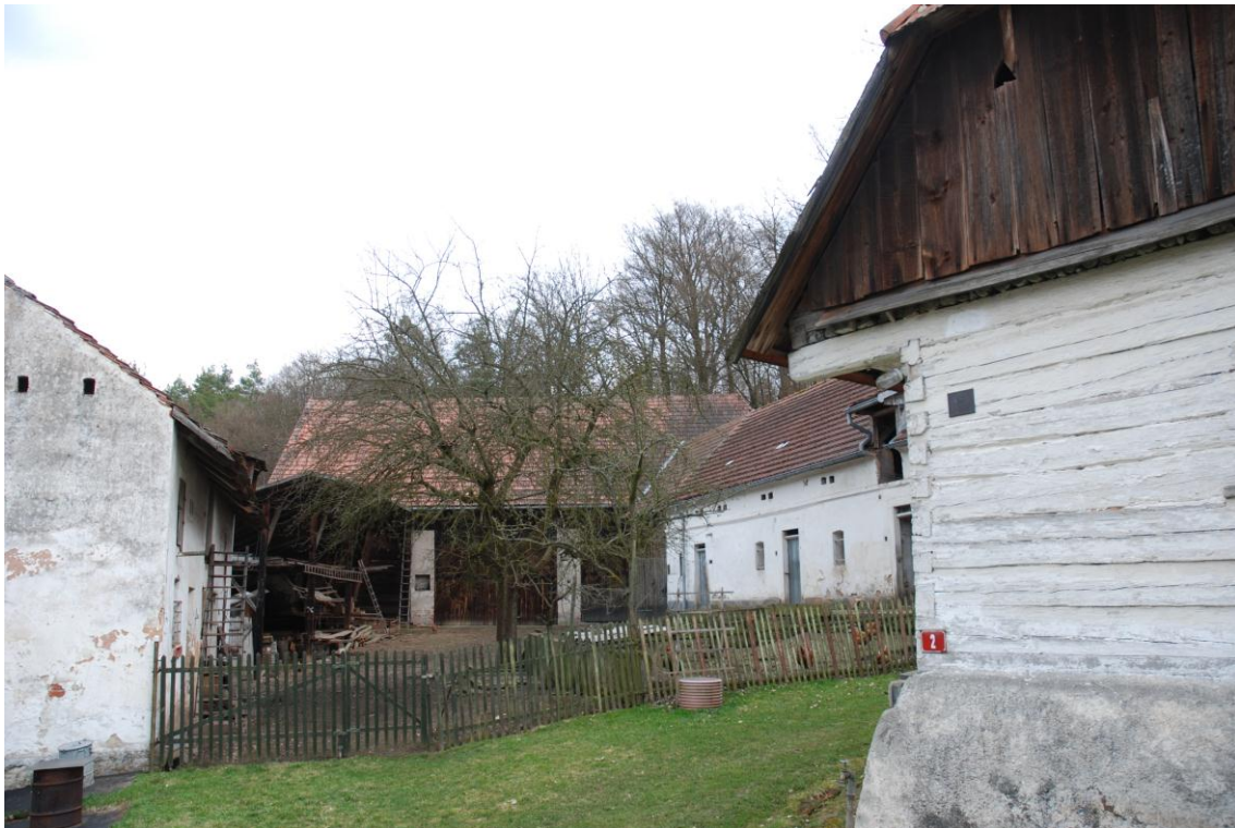
Obr. 8: Rybnice, roubená konstrukce domu č. p. 2, hospodářské zázemí (foto Pavuková)
