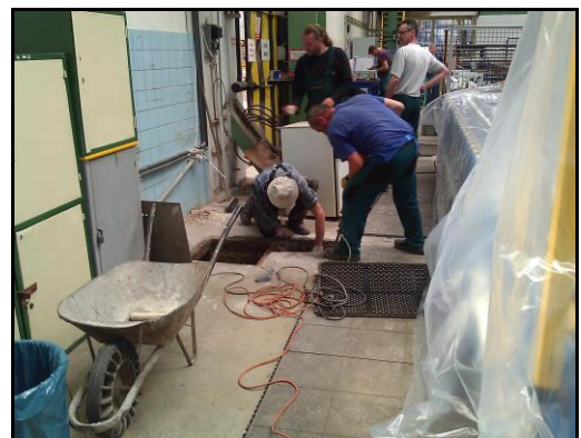
Obr. 4.5 Instalace kabelového rozvodu
