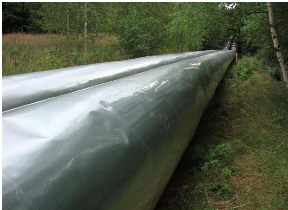
Obr. 2 - Povrchová ochrana exteriérového potrubí nekovovou folií
