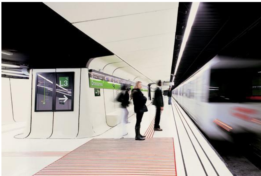
Obrázek č. 8 – Barcelonská stanice metra Drassanes – pohled do stanice
