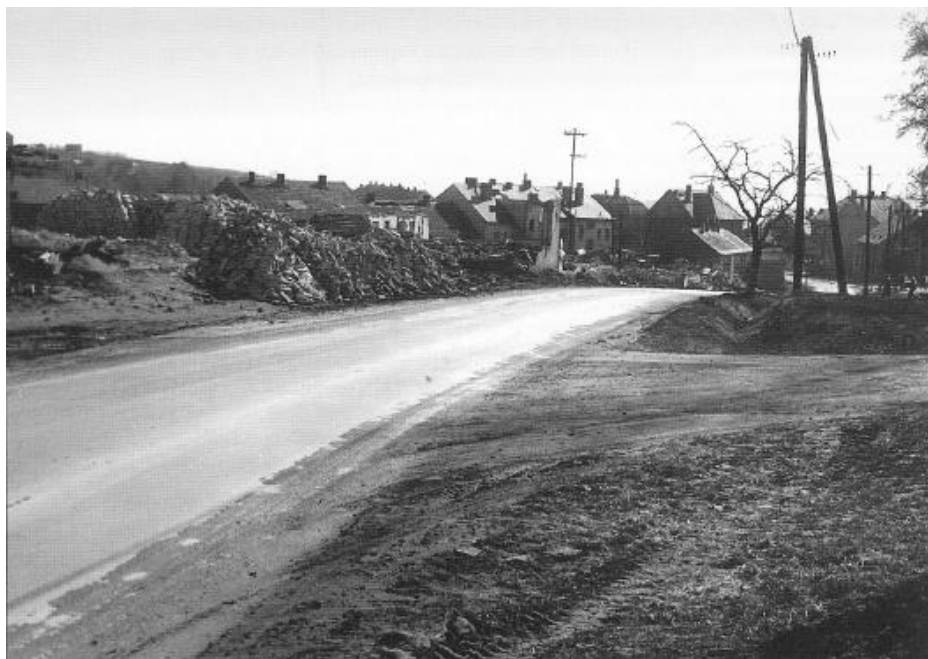
Obr. 18 Demolice v nynější Ledecké ulici (dříve Tyršova) v 70. letech 20. století (z archivu Sdružení boleveckých rodáků).
