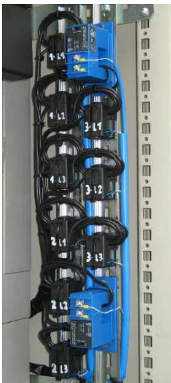
Obr. P2 - 1: Měření proudů pomocí průvlekových PTP - převzato z [P2-3]
