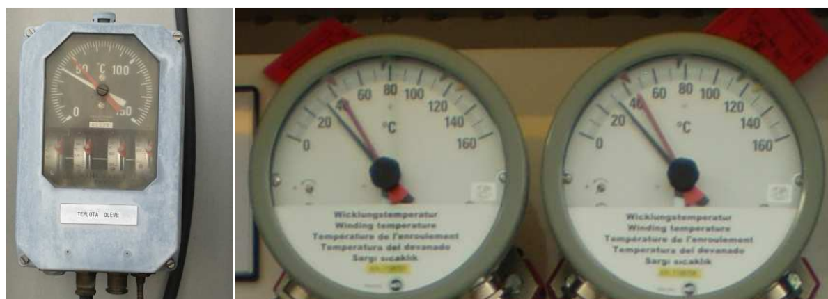
Obr. 15: Měření teploty oleje (vlevo) a teploty vinutí (vpravo)
