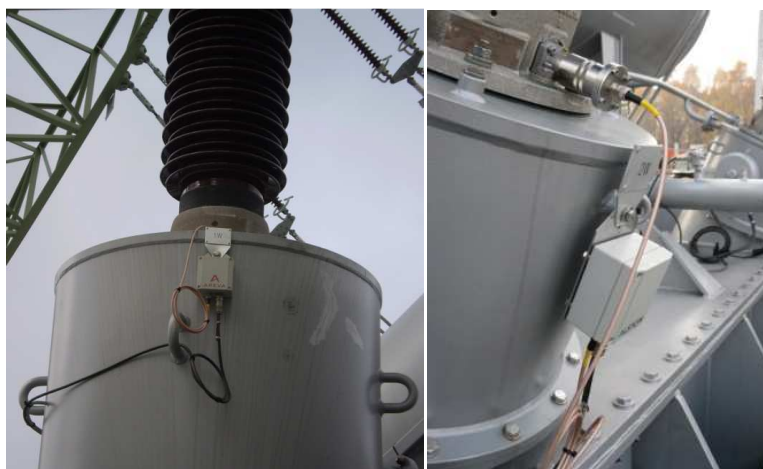
Obr. P2 - 2: Ukázka zapojení senzoru s adaptérem do měřicího vývodu průchodky
