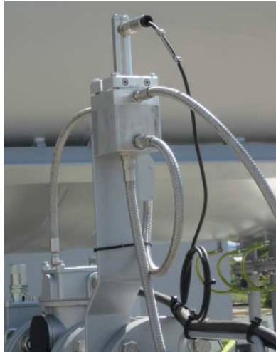
Obr. 16: Buchholzovo relé senzor
