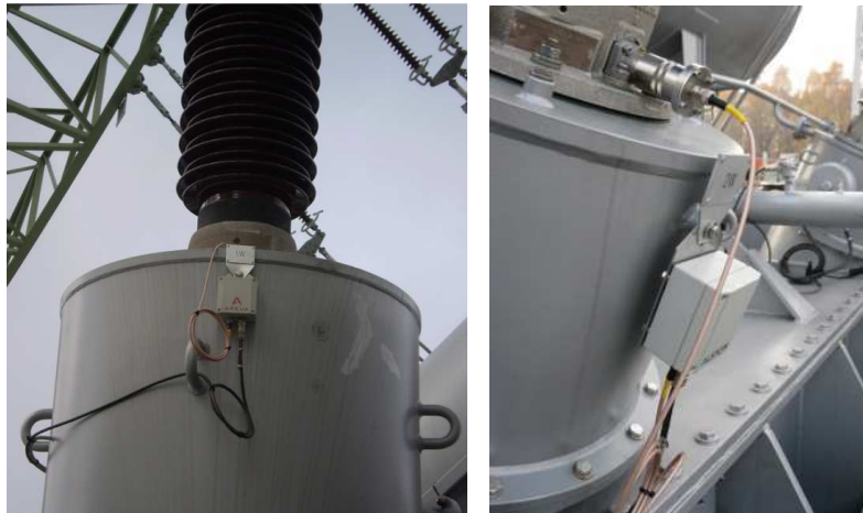
Obr. 13: Ukázka zapojení senzoru s adaptérem do měřicího vývodu průchodky
