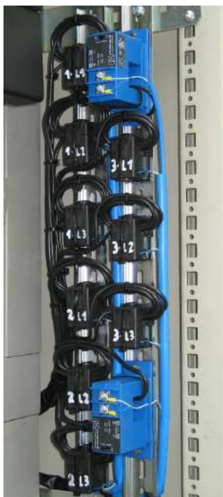
Obr. 12: Měření proudů pomocí průvlekových PTP - převzato z [28]
