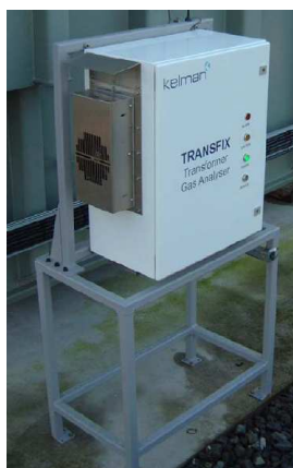
Obr. P2 - 10: Umístění multi-gas senzoru Transfix – převzato z [P2-16]
