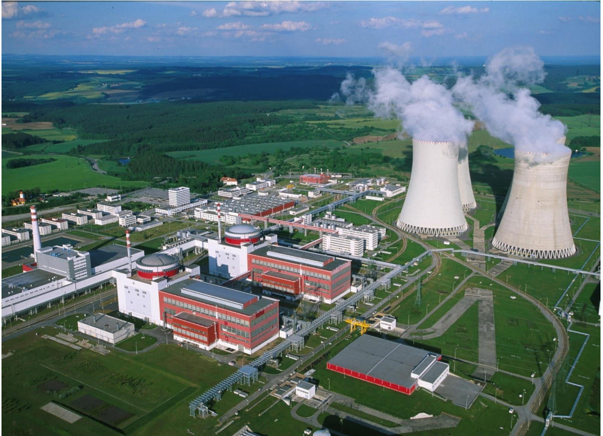
Obr. 4 JE Temelín 2x1055MW [20]
