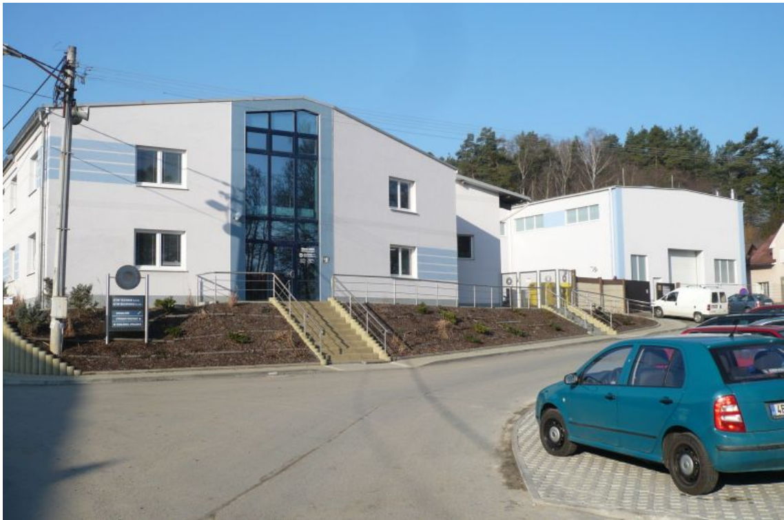
Zdroj: GTW BEARINGS s.r.o., administrativní budova
