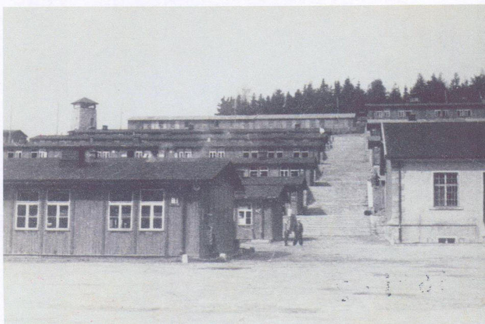
vpravo kuchyně - vedle schodiště smrti
