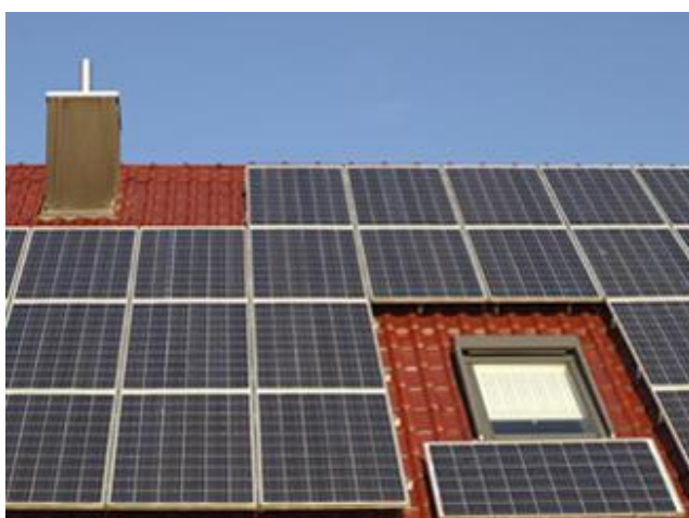
Obr. 26: Instalace PV panelu s rozdílnou orientací k sousedícím panelům a k zemi [38]
