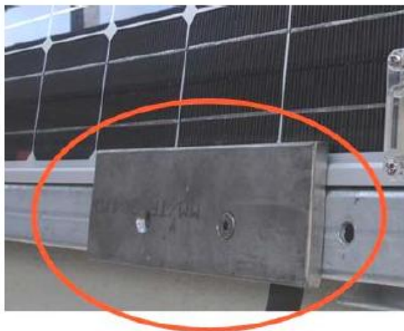
Obr. 24: Zastínění PV článků [KEE/SOES]
