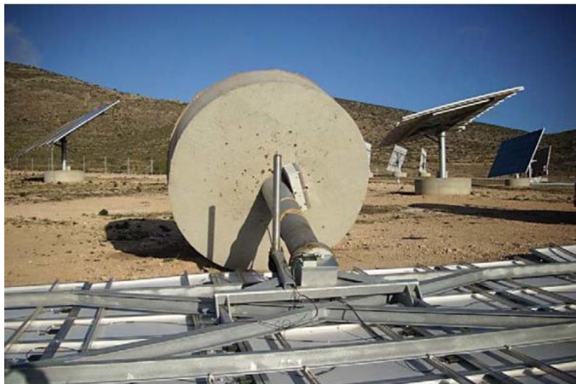
Obr. 34: Povalení PV panelu větrem [32]
