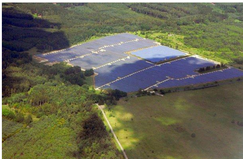
Obr. 25: Nerovnoměrné zastínění PV elektrárny [37]
