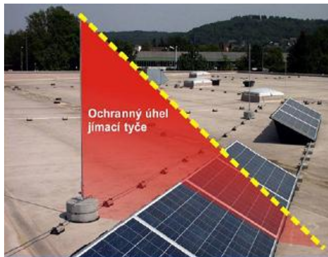
Obr. 31: Vzájemná poloha jímacích tyčí a PV panelů [14]
