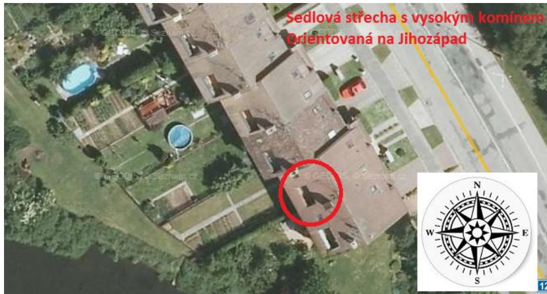
Obr. 78: PV elektrárna na sedlové střeše, ne příliš optimálně orientovaná na jih [65]
