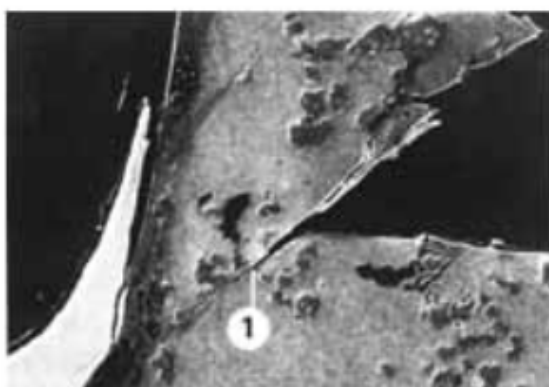
Obr. 2-5: Prasklina při oddělování tvrdého materiálu [23]
