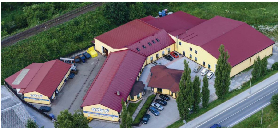
Obr. 1.7: Současné prostory firmy ASTRO KOVO Plzeň s.r.o. [11]
