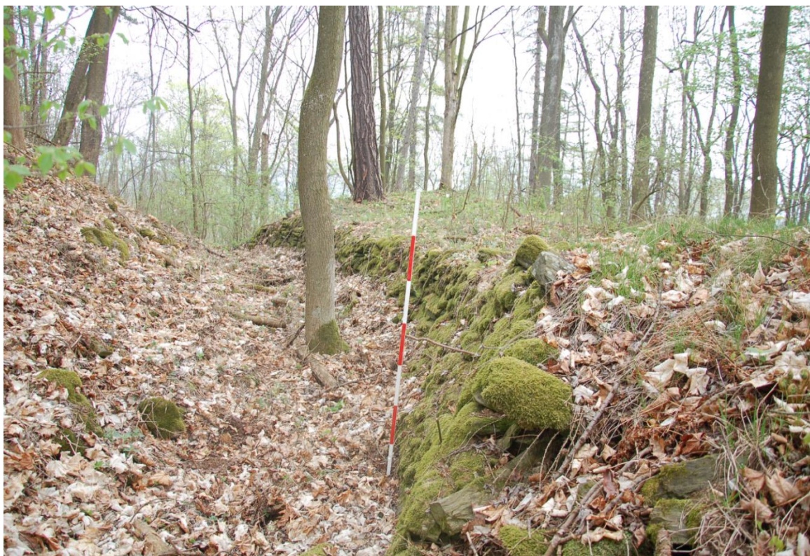
Obr. 40: Vnitřní kamenná plenta valového tělesa na východní straně (foto autor).
