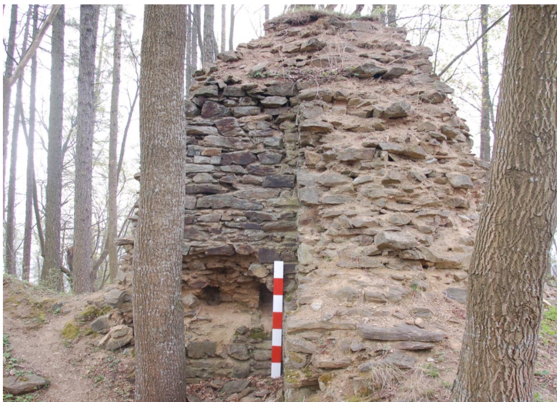
Obr. 25: Kapsy po stropních trámech ve východním koutě donjonu (foto autor).
