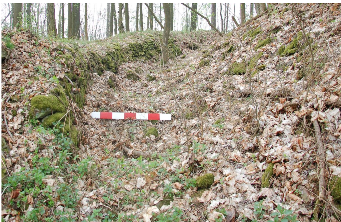
Obr. 37: Vnitřní kamenná plenta valového tělesa na východní straně (foto autor).
