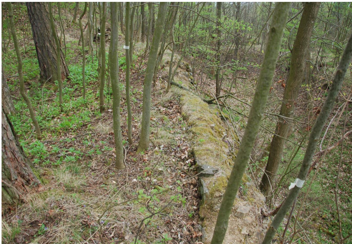
Obr. 30: Relikt oboustranně lícované poprsní zdi (foto autor).
