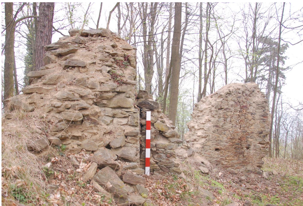
Obr. 23: Styk obvodové zdi donjonu a novověké příčky v jeho interiéru (foto autor).
