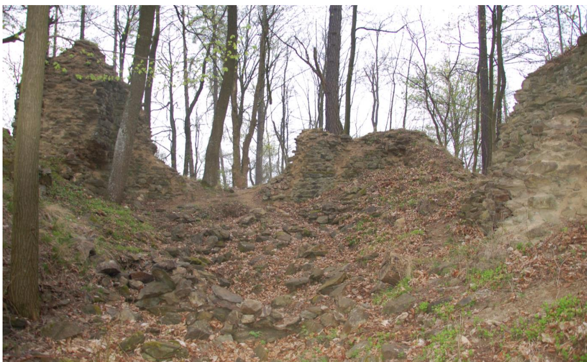
Obr. 27: Interiér donjonu s destrukcí zdiva souvisejícího částečně s novověkou kaplí (foto autor).
