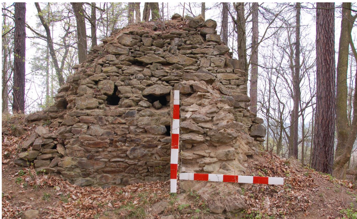
Obr. 22: Zdivo příčky oddělující loď kaple od původního presbytáře (foto autor).
