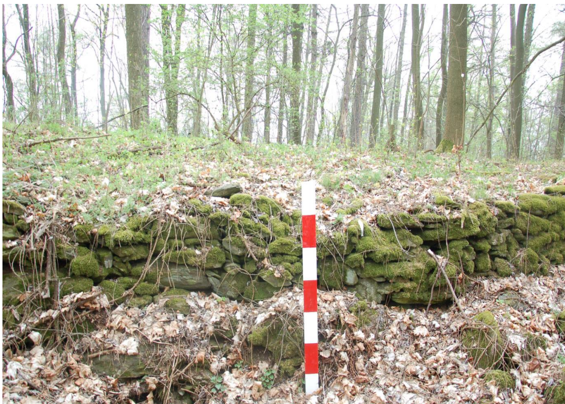
Obr. 38: Vnitřní kamenná plenta valového tělesa na východní straně (foto autor).
