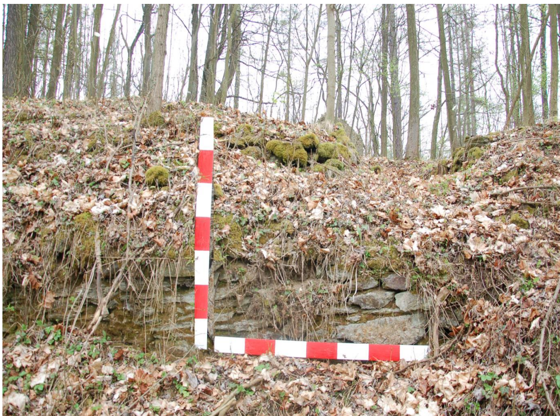
Obr. 34: Obvodová hradba na severní straně obnažená vývratem (foto autor).
