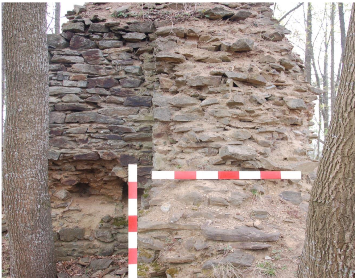
Obr. 26: Trámové kapsy a odsazení zdiva pro uložení podlahy prvního patra donjonu (foto autor).
