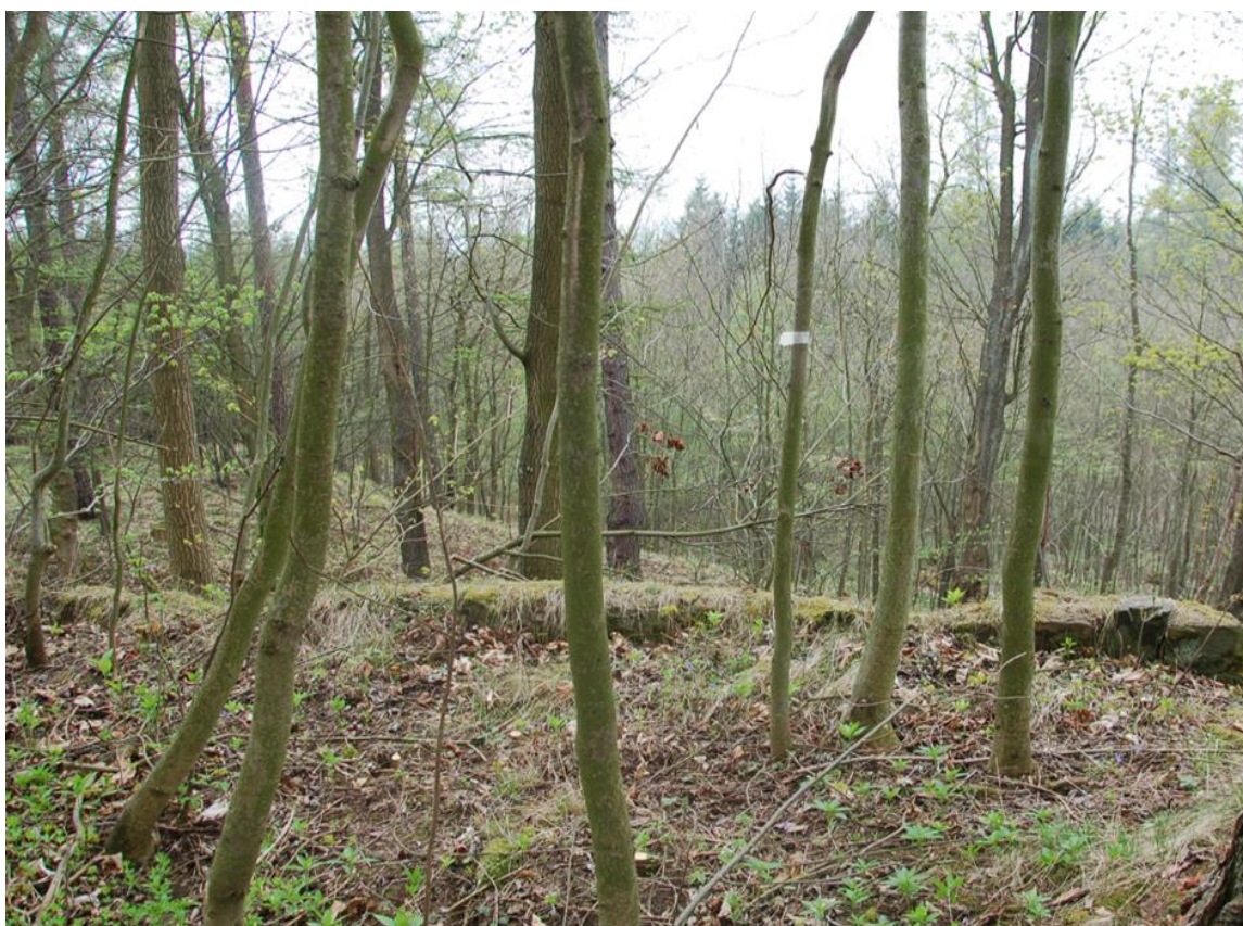
Obr. 31: Úroveň terénu před pozůstatky oboustranně lícované poprsní zdi (foto autor).
