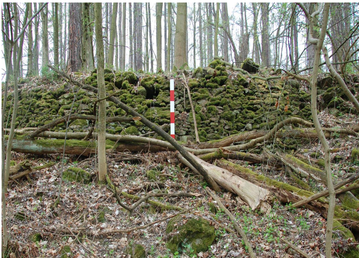
Obr. 36: Vnější kamenná plenta valového tělesa na východní straně (foto autor).
