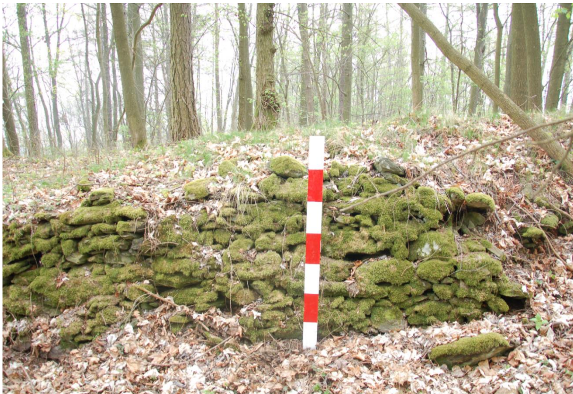
Obr. 39: Vnitřní kamenná plenta valového tělesa na východní straně (foto autor).
