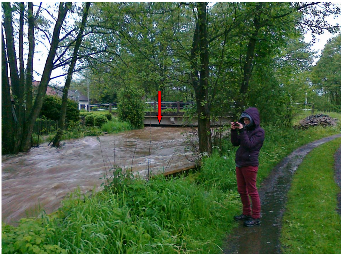
Obr. č. 9, Most v obci Kašovice značně omezující průtok řeky. Situace při povodni 2013, vodní stav 98 cm 2. SPA (3. SPA 100cm), Foto T. Ulč 2013
