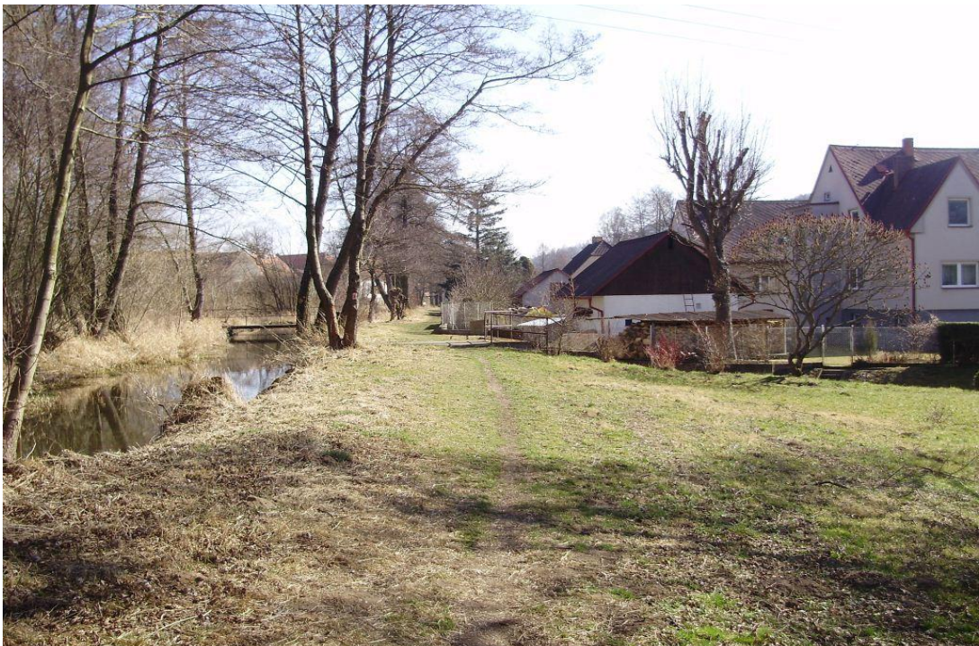
Obr. č. 7 , vodní náhon nad úrovní zástavby, Hrádek u Sušice. (zástavba je částečně chráněna přepadovým odvodňovacím korytem viz Obr. č. 8 ), Foto T. Ulč 2014
