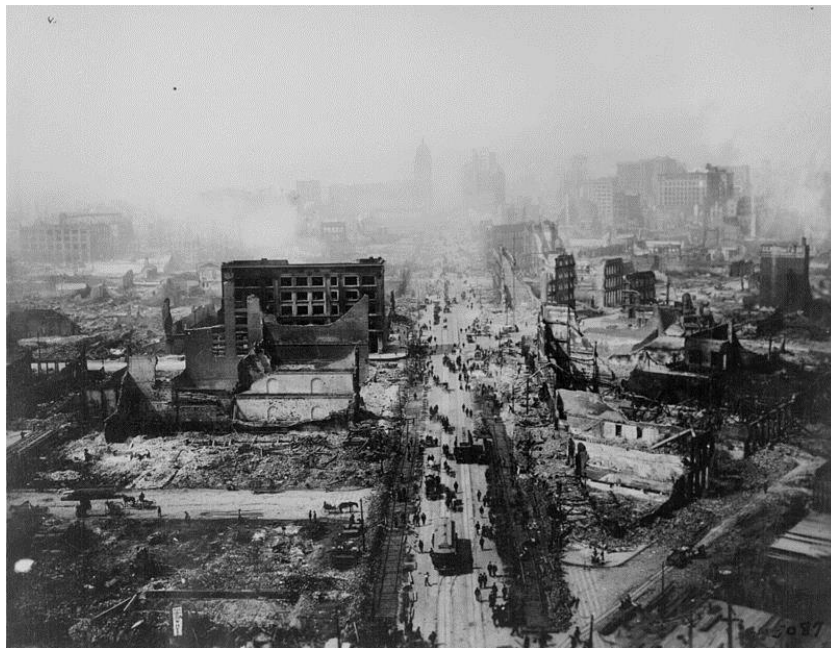
Obr. 3.1 Následky zemětřesení v San Franciscu (1906)
