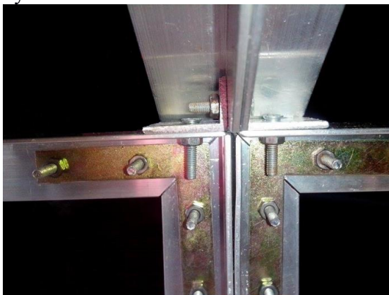
Obrázek 2 - Spojení střechy se základnou
