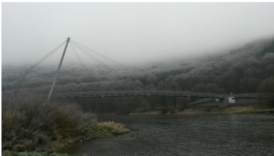
Obr. č. 15: Lávka přes řeku Berounku
