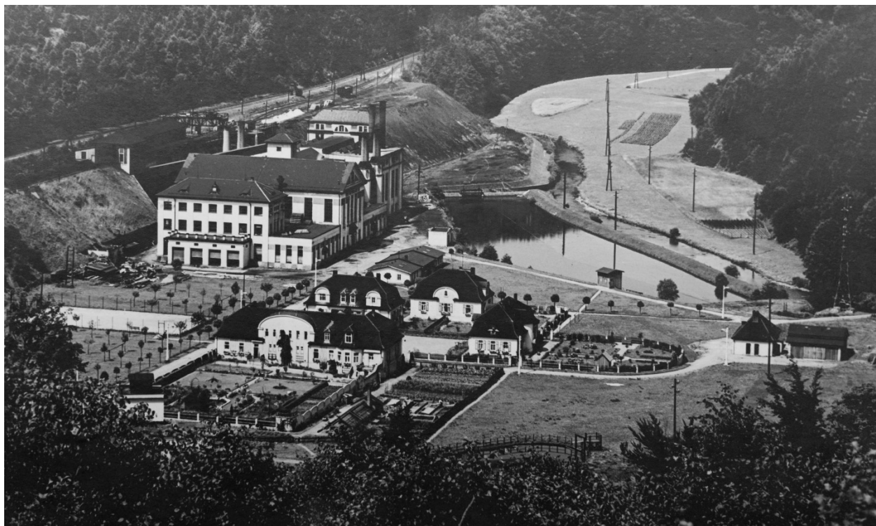
Obr. 4: Elektrárna (soukromá sbírka)
