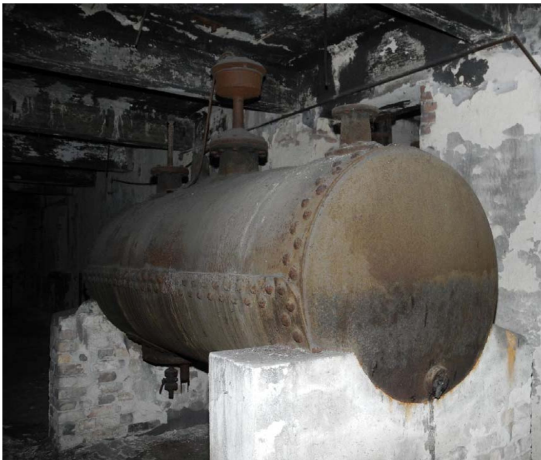
Obr. 32: Tlaková nádoba s plovákovou hladinovou regulací (vlastní foto)
