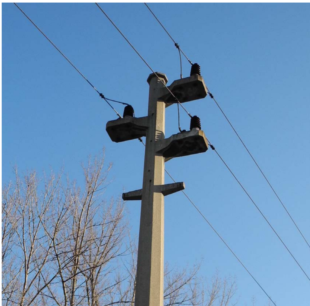
Obr. 44: Betonový sloup bývalého vedení 20 kV (vlastní foto)
