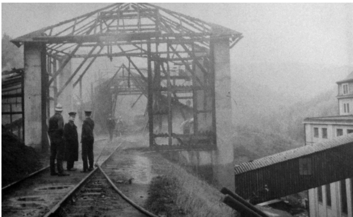
Obr. 6: Požár uhelného bunkru (SOKa Liberec, archiv města Liberce)
