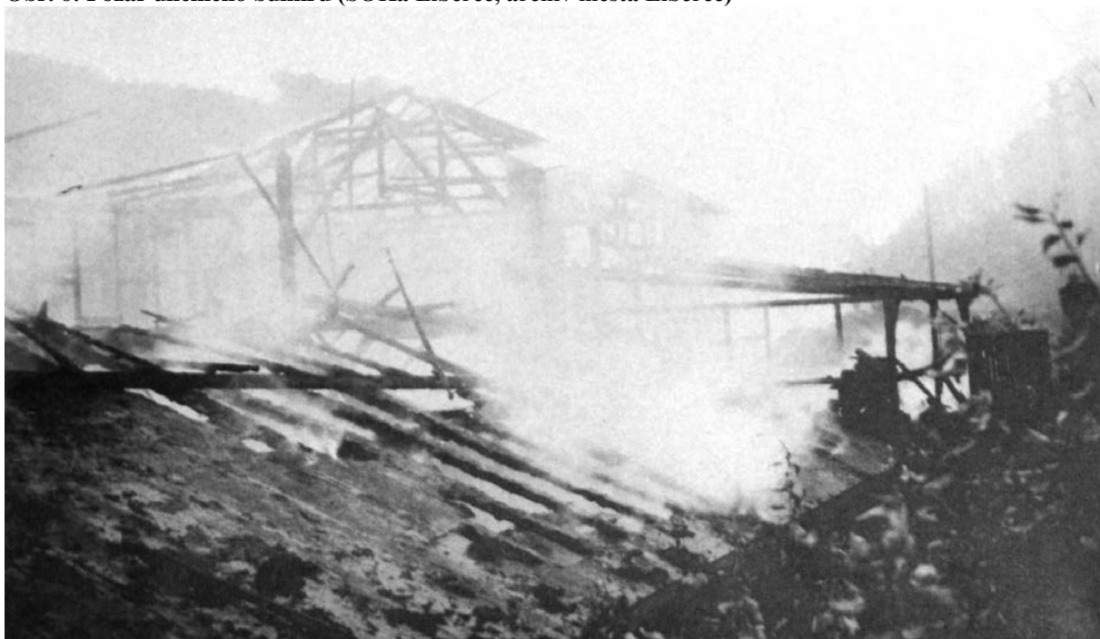
Obr. 7: Požár uhelného bunkru (SOKa Liberec, archiv města Liberce)
