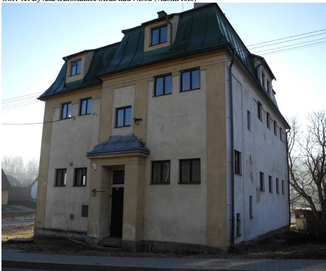
Obr. 42: Bývalá trafostanice Mníšek (vlastní foto)
