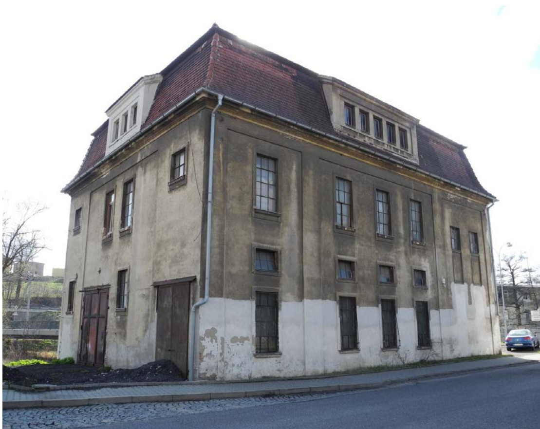
Obr. 41: Bývalá trafostanice Stráž nad Nisou (vlastní foto)
