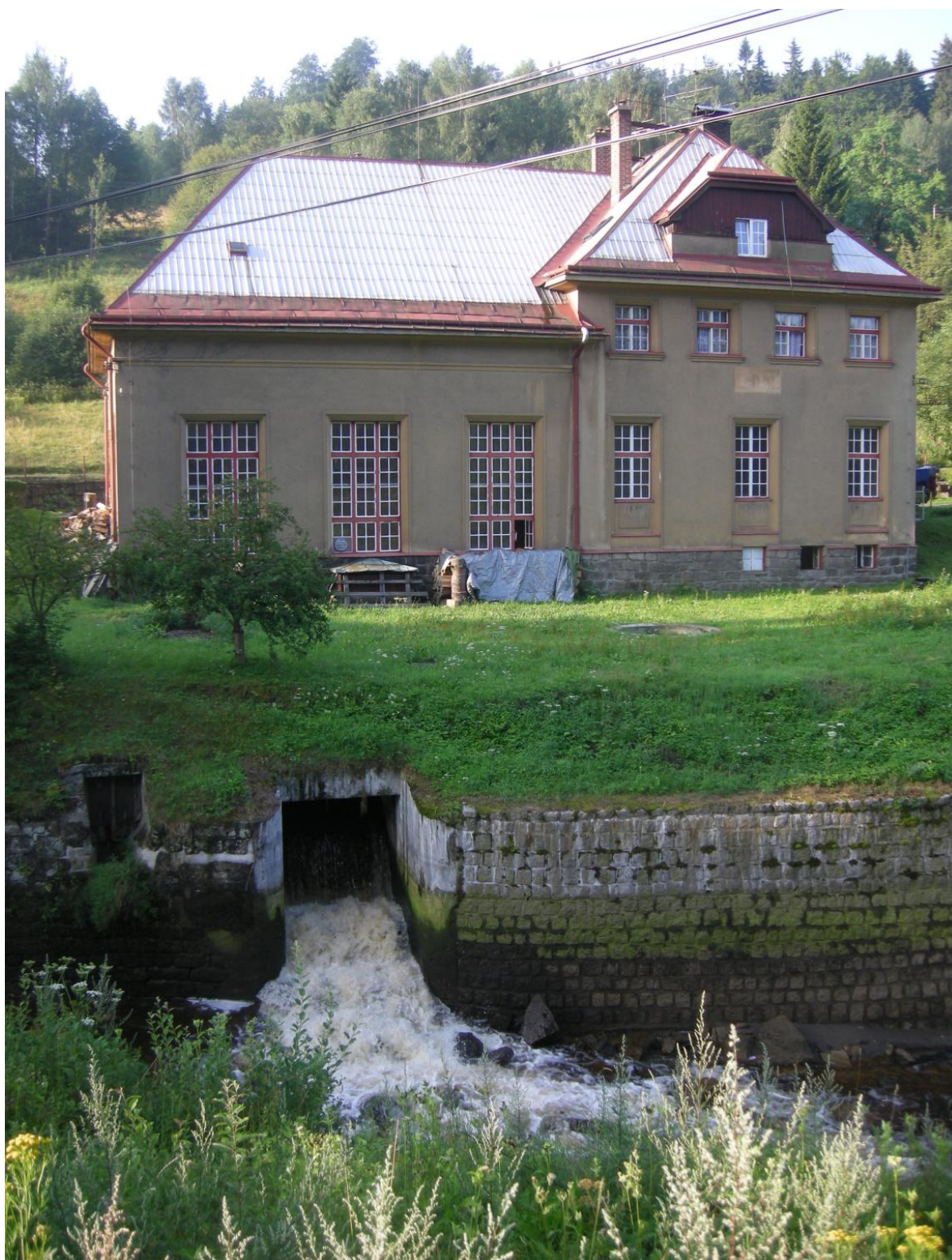
Obr. 36: Budova MVE Rudolfovo (vlastní foto)
