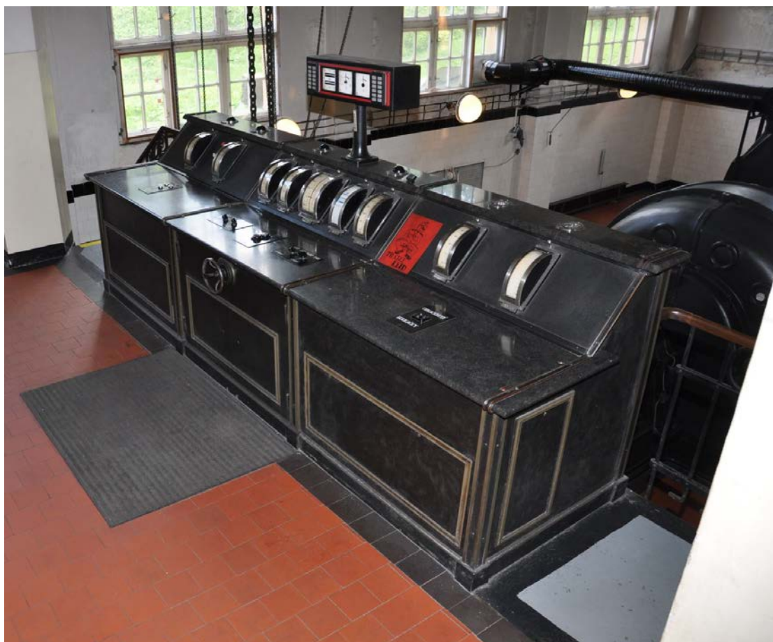
Obr. 37: Ovládací pult MVE Rudolfov (vlastní foto)
