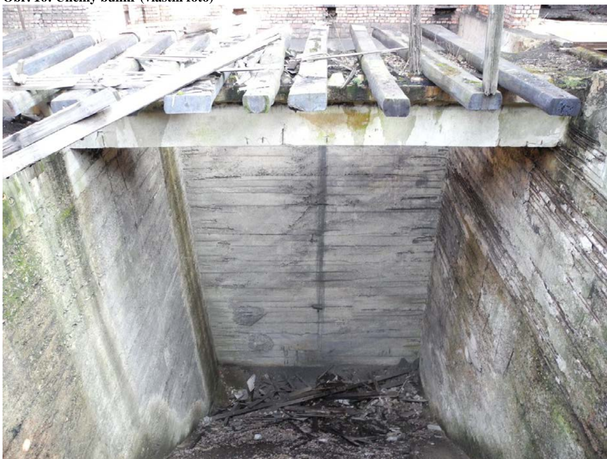
Obr. 17: Komora uhelného bunkru (vlastní foto)
