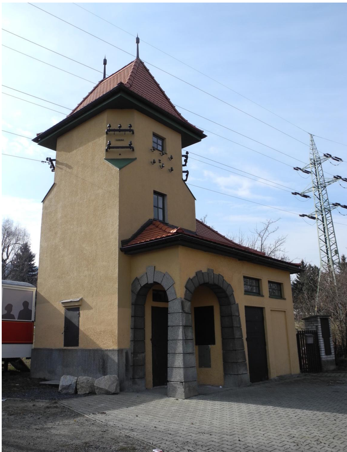
Obr. 43: Bývalá distribuční věžová trafostanice v Horním Hanychově (vlastní foto)
