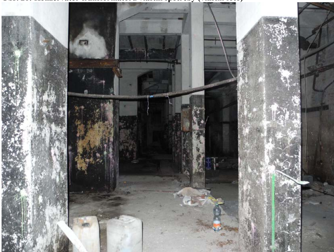
Obr. 27: Prostor pod strojovnou (vlastní foto)
