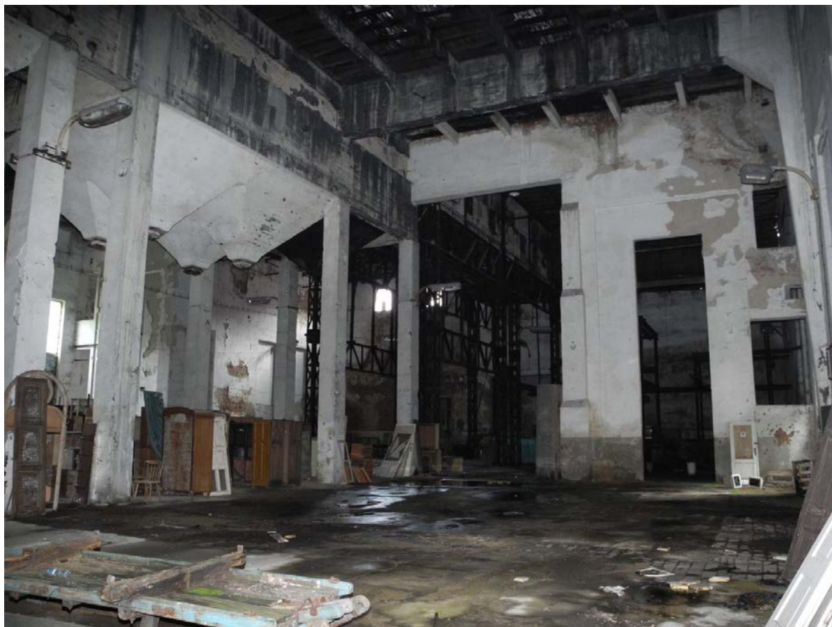
Obr. 30: Prostor kotelny (vlastní foto)
