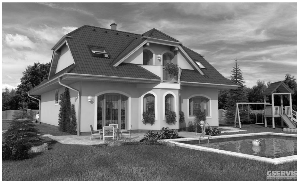
Obr. 7.1 Celkový pohled na budovu [23]
