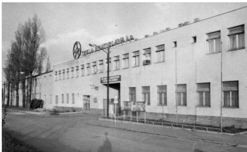
Obr.10: Průčelí bratislavského závodu, vstupní část a výrazný nápis TESLA BRATISLAVA k.p. doplněný firemním znakem na střeše budovy. Archiv ŽTM
