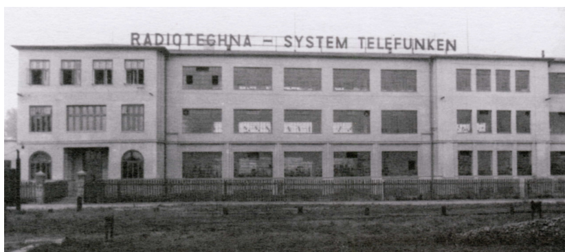
Obr.2: Tovární objekty přeloučského závodu s výrazným označením firmy. [13]
