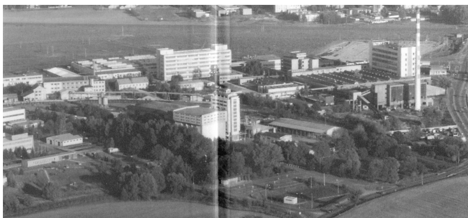
Obr.19: Letecký pohled na areál býv. závodu Vrable ještě se stojící dominantou, komínem kotelny s nápisem TESLA, dnes "úspěšně" zdemolovaným. (Omluvte prosím sníženou kvalitu náhledu, snímek pochází z předzázky knihy [12].)
