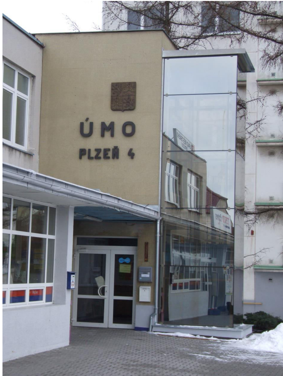
2. Nevhovující zrcadlová stěna[2]
