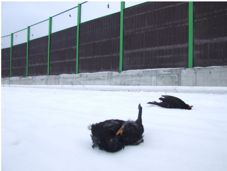
4. Ptáci po kolizi s protihlukovou bariérou Čechurov, Plzeň [2]
