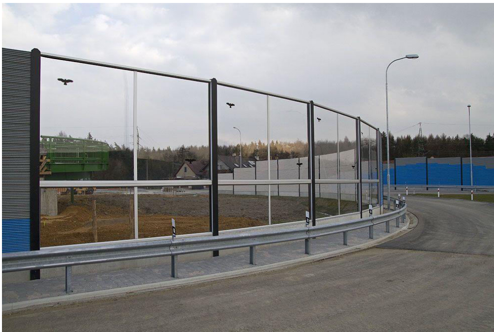
3. Nevhodně řešená protihluková stěna Domažlická ulice, Plzeň[2]
