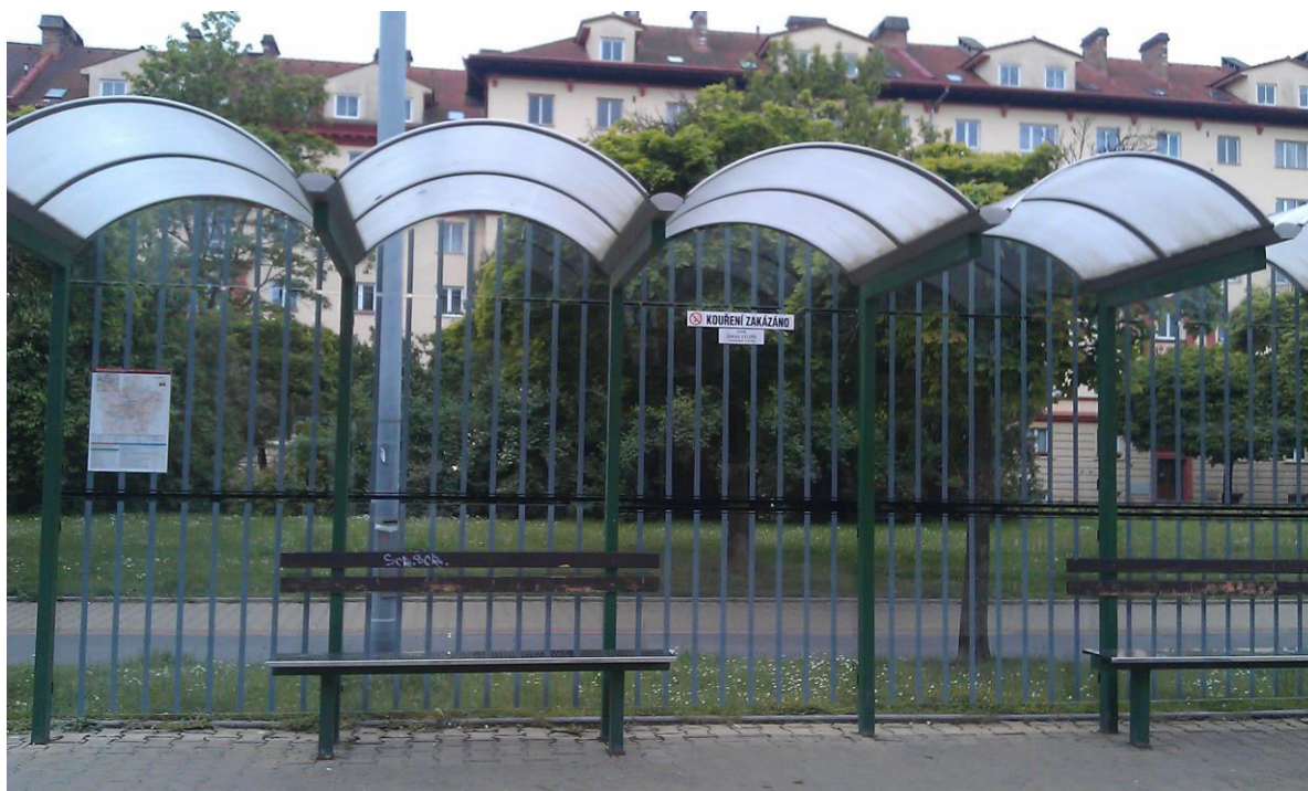
8. Správně řešená zastávka [3]
