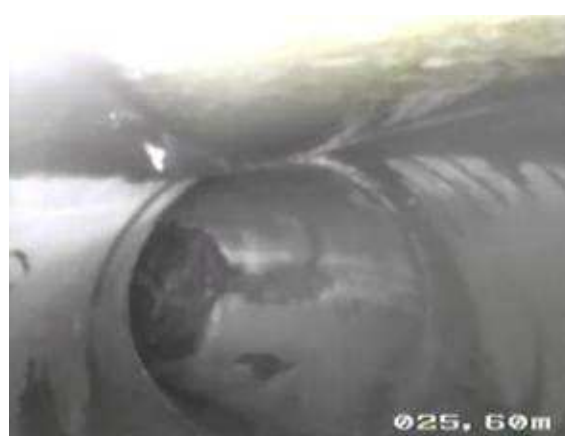
Obr. 3.10 Nečistoty nalepeny na stěnách
