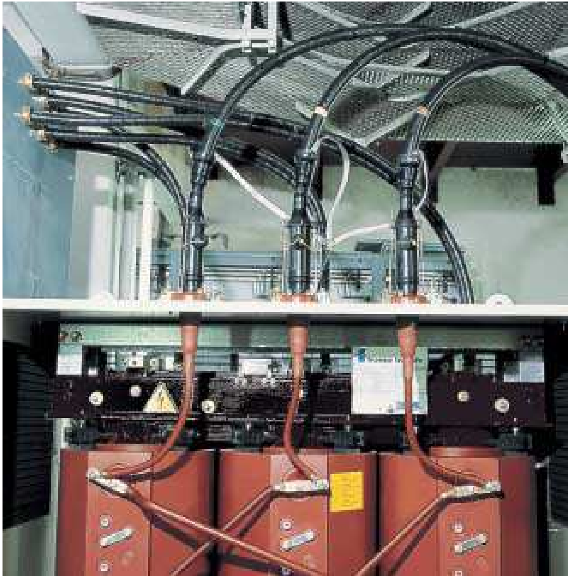
Obr. 4 Připojení VN kabelu na TR [1]
