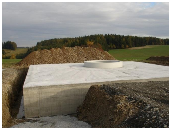
Obr. 10: Betonový armovaný základ VtE. [15]
