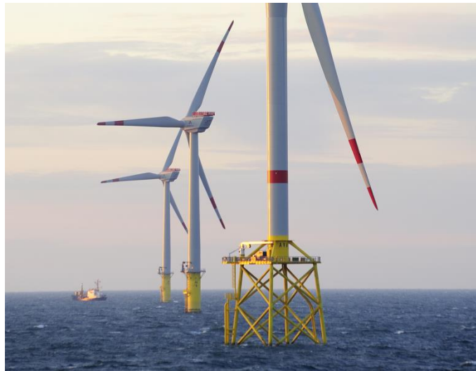
Obr. 31: Německá větrná farma Alpha Ventus s viditelným rozdílem v použitých typech základové konstrukce. [42]
