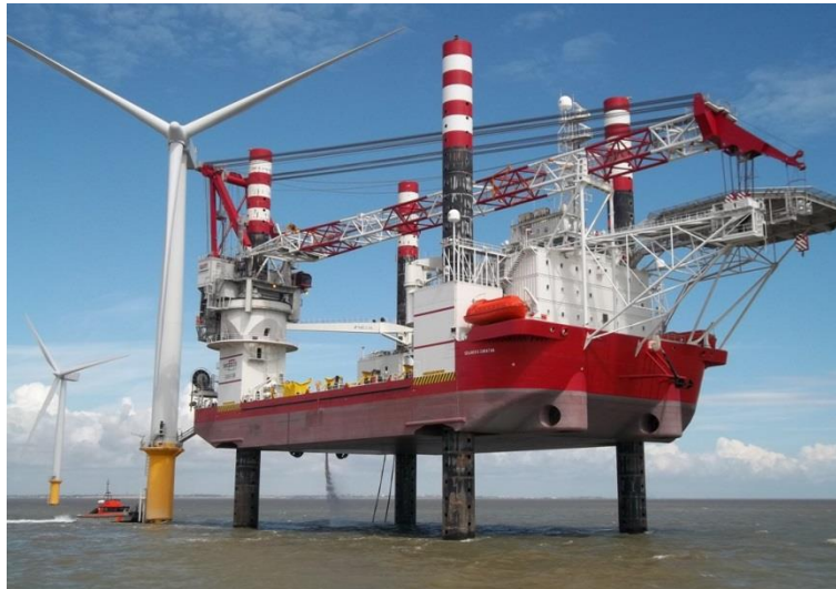
Obr. 21: Instalační loď Seajacks Zaratan kompletuje pobřežní větrnou elektrárnu. [39]
