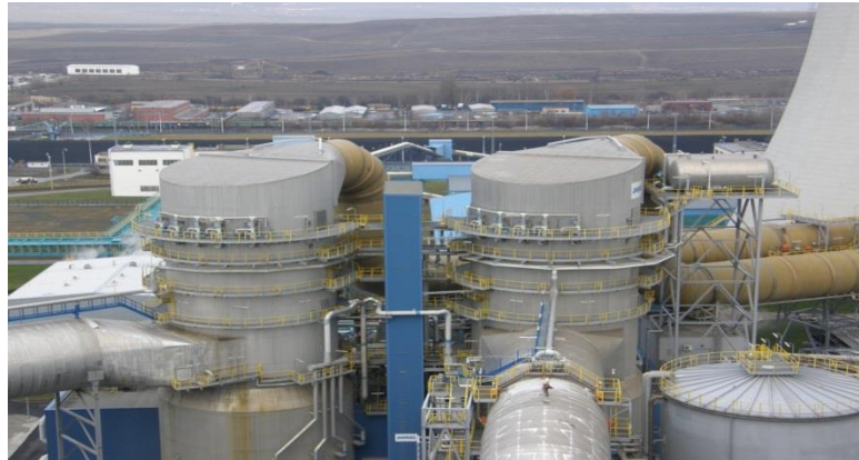
Obr. 4 - Mokrá vápencová propírka - elektrárna Tušimice II
