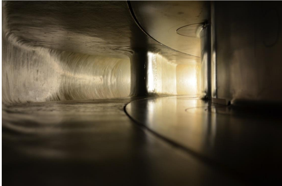
Obr. 9 - Přívodní spirála a rozváděcí kolo Francisovy turbíny PVE Dlouhé Stráně
