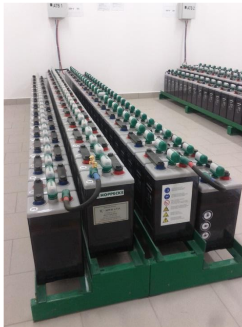
Obr. 7 - Akumulátorový blok
