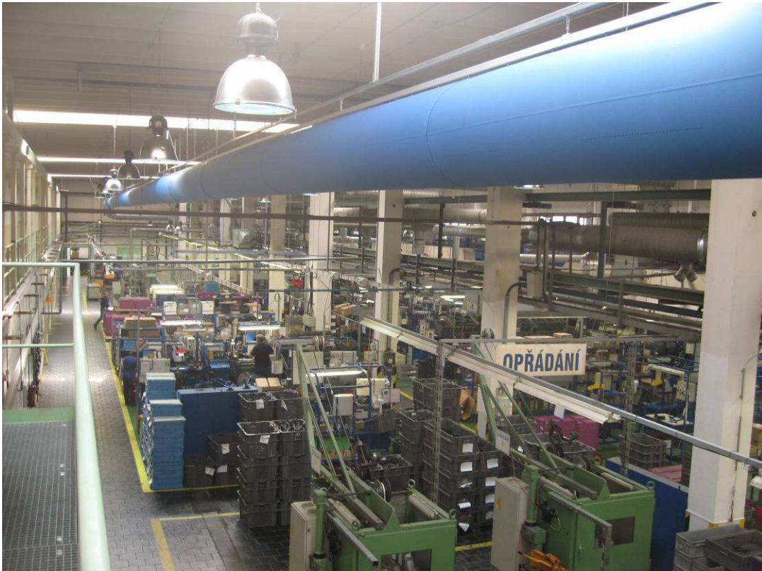
Obr. 2.2 Vnitřní prostor výrobní haly B
