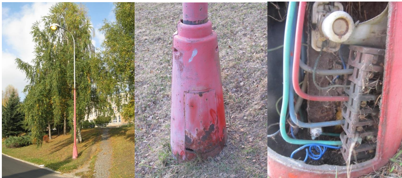
Obr. 4.8: Stávající stožár Zb7-5 a detail patice stožáru a svorkovnice [vlastní foto]
