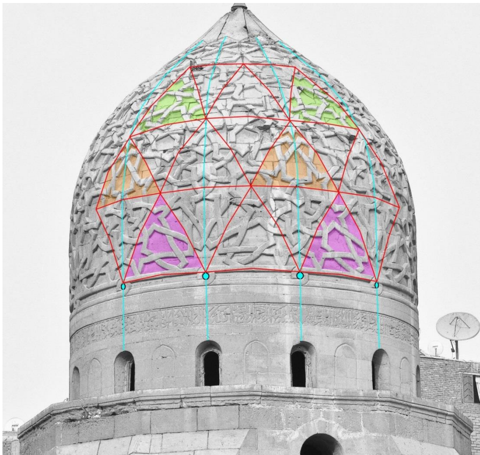
↑ Obr. 35: Azurově modré čáry vyznačují osy „mīm“, které jsou základem pro rozvržení dekorativního schématu kopule. Červeně je znázorněna teselační síť. Zeleně, oranžově a fialově jsou vyznačena pole se stejným vzorem.
