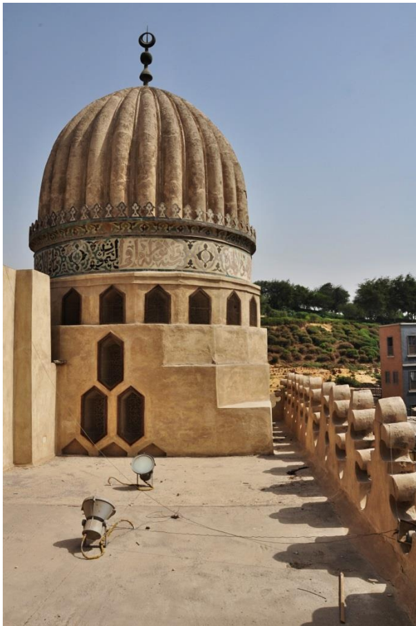
↑ Obr. 55: Stupňovitá přechodová zóna, Qubba Guzal an-Nāširi.
