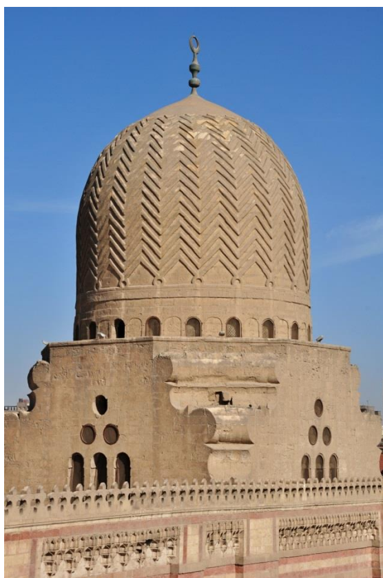
↑ Obr. 58 a 59: Vlevo zvlněná přechodová zóna pod kopulí mauzolea sultána al-Muʿajjada Šajcha; vpravo pod kopulí chānqāhu Faradže ibn Barqūqa.
