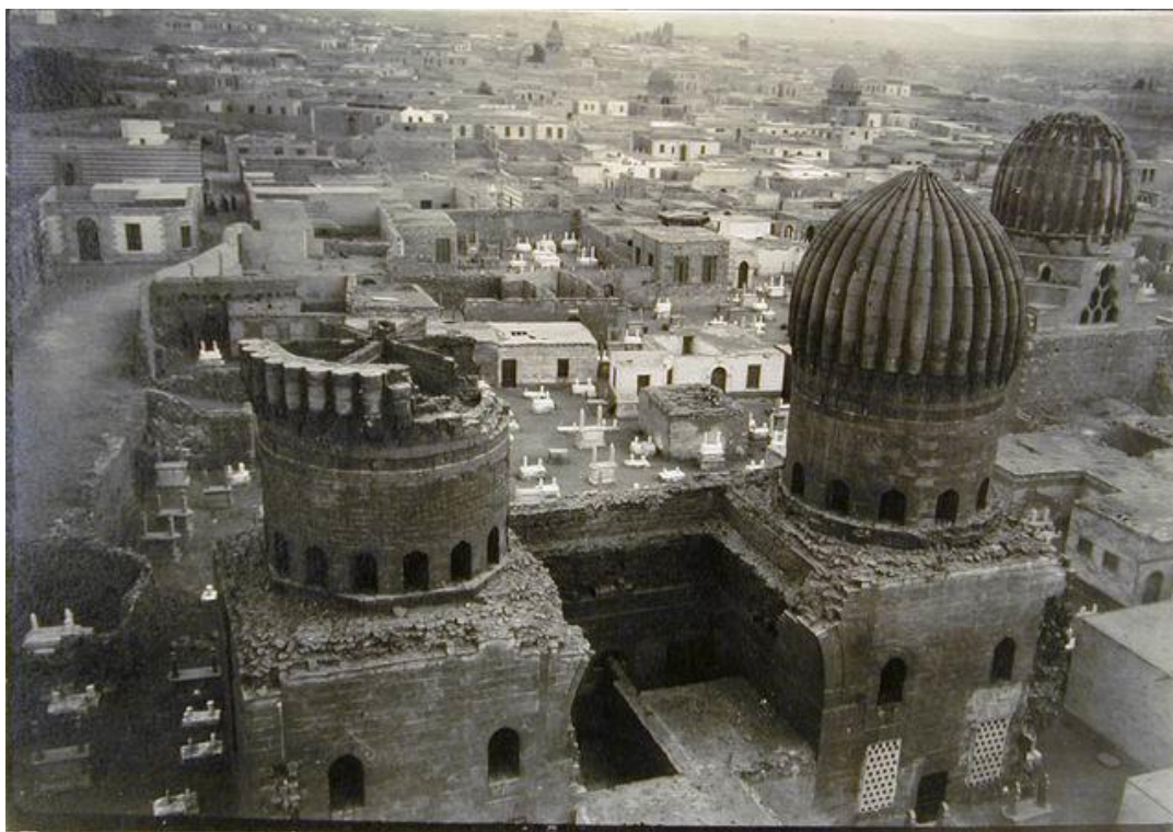
↑ Obr. 20: Fotografie as-Sulṭānīje pořizená K.A.C. Creswellem před rekonstrukcí v 80. letech 19. století. Pod téměř úplně zničeným vnějším kamenným pláštěm SV kopule je vidět část cihlové podpůrné konstrukce. Zdroj: CRESWELL, K. A. C. Qubba al-Turba al-Sultaniyya. [cit. 10.3.2015]. © Creswell Archive, Ashmolean Museum, neg. EA.CA.3325. Image courtesy of Fine Arts Library, Harvard College Library.
