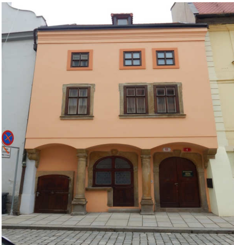
Obrázek 24 Dům s vysunutým patrem na krakovcích v Perlové ulici čp. 65. Zdroj: Foto autorky práce.
