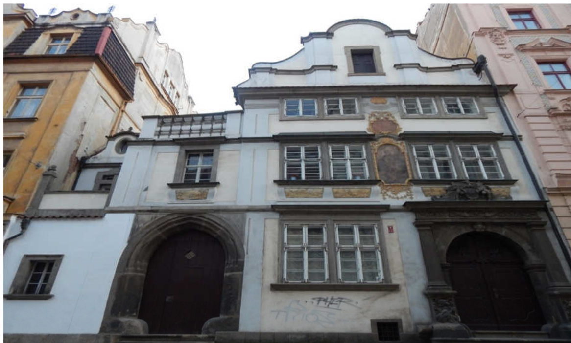
Obrázek 20 Gerlachovský dům již s barokní fasádou. Vlevo gotický portál vpravo portál renesanční. Zdroj: Foto autorky práce.
