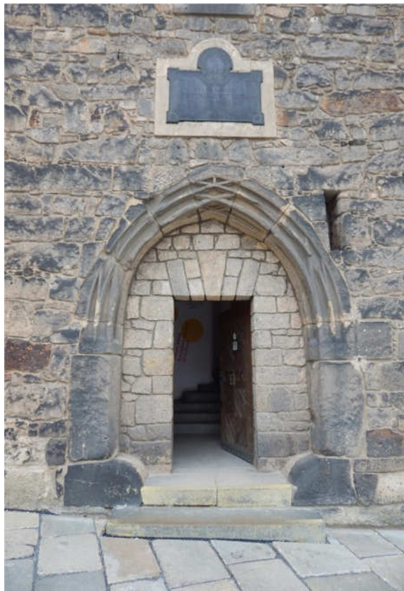
Obrázek 12 Gotický portál na vodárenské věži. Zdroj: Foto autorky práce.
