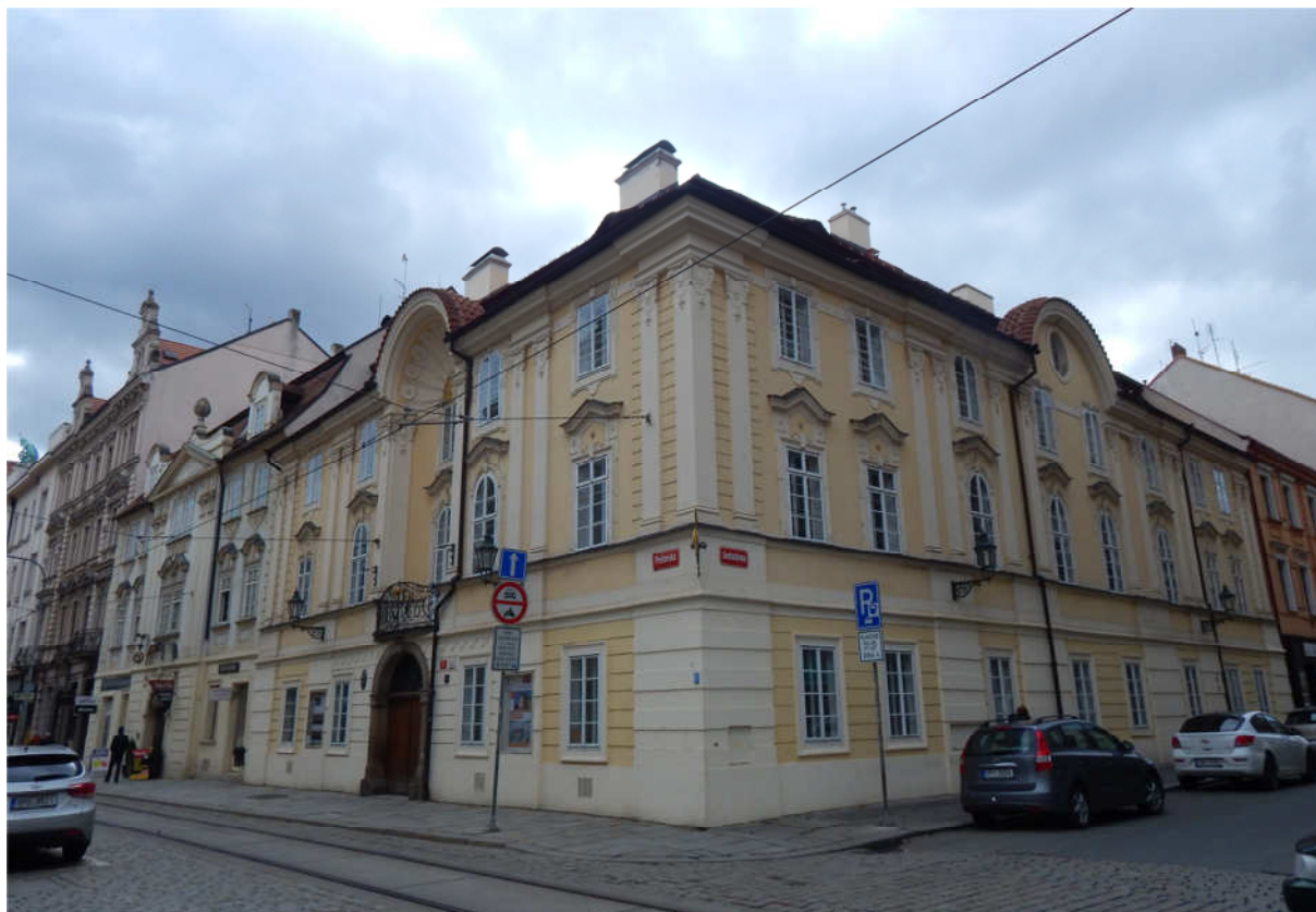
Obrázek 30 Barokní dům U zlatého slunce v Prešovské ulici čp. 171. Zdroj: Foto autorky práce.
