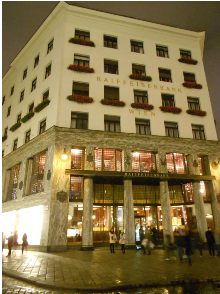
Obr. 15: Looshaus (zdroj: vlastní foto, 2014)
