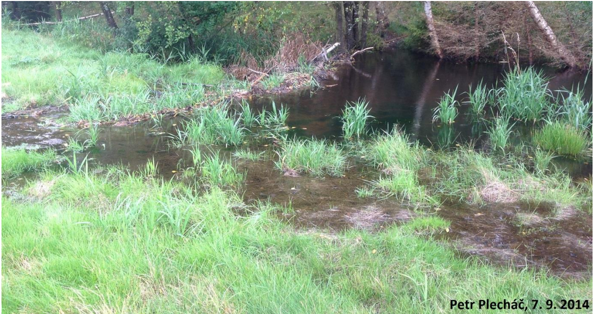
Obr. 44: Bobří hráz a obtékání vody přes zemědělskou půdu, 7. 9. 2014
