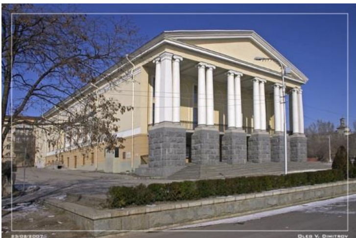
Obrázek č. 34: Budova městské vodárny
