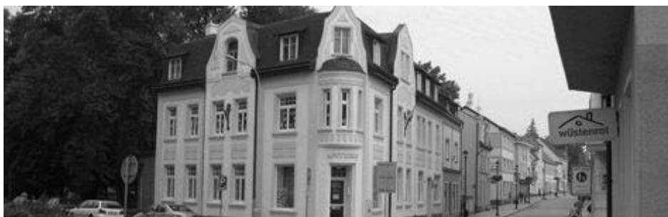
Obrázek 4 Fotografie historické budovy MěK Chodov
