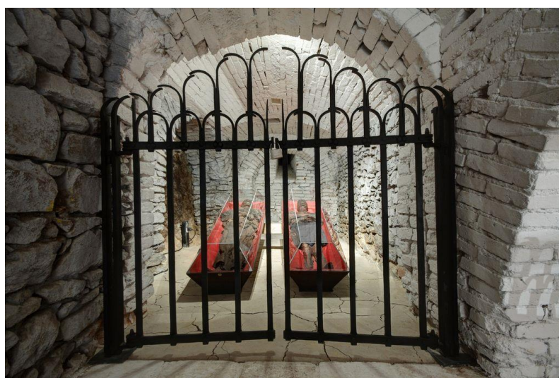
Obrázek č. 18 – 20 (klatovská krypta po rekonstrukci v roce 2011)
