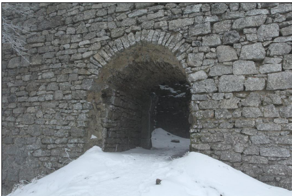
Obr. 16: Kunžvart. Vstup od severu opatřený portály v obou lících. Foto A. Pojarová.
