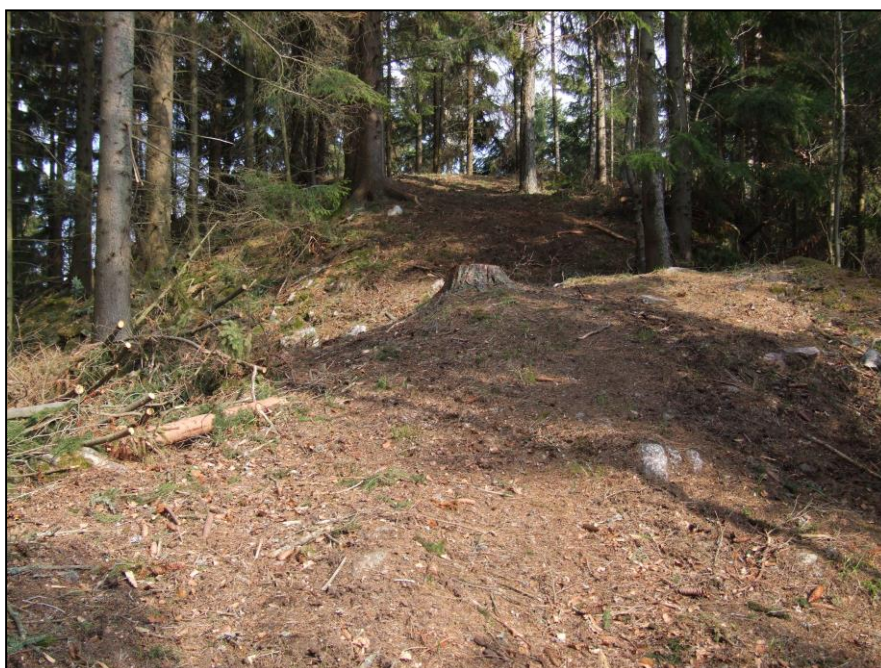
Obr. 24: Hausberk hrad. Přístupová komunikace za příkopem, v pozadí valovitý relikt čelní fortifikace. Foto A. Pojarová a J. Hložek.
