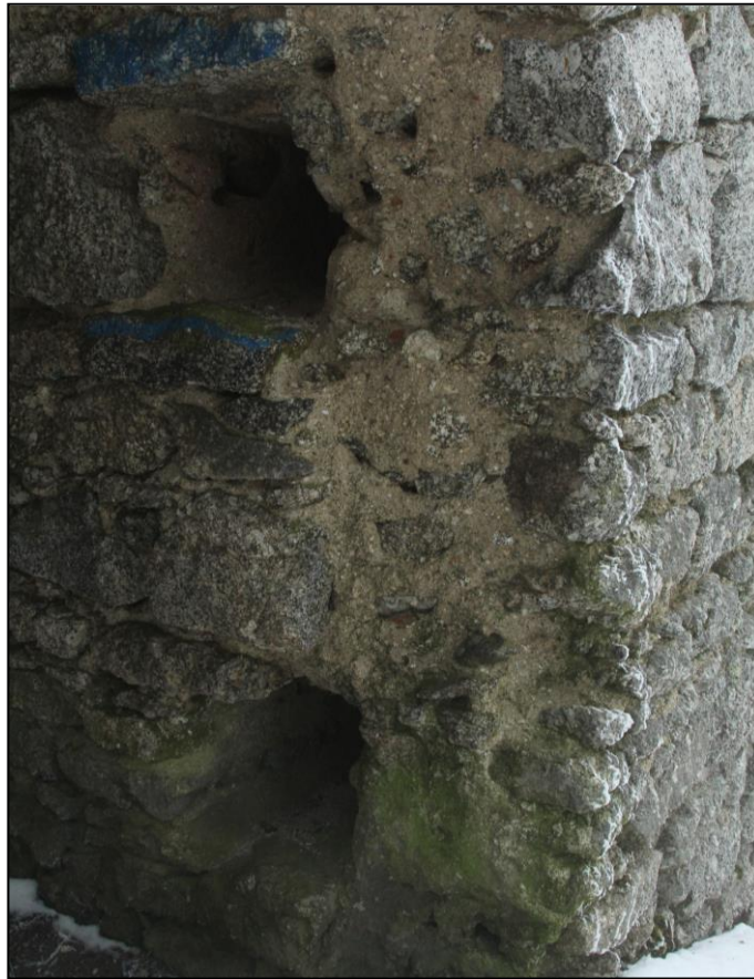
Obr. 17: Kunžvart. Trámové kapsy pro mohutnou závoru. Foto A. Pojarová.
