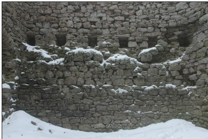
Obr. 17: Kunžvart. Trámové kapsy pro mohutnou závoru. Foto A. Pojarová.
