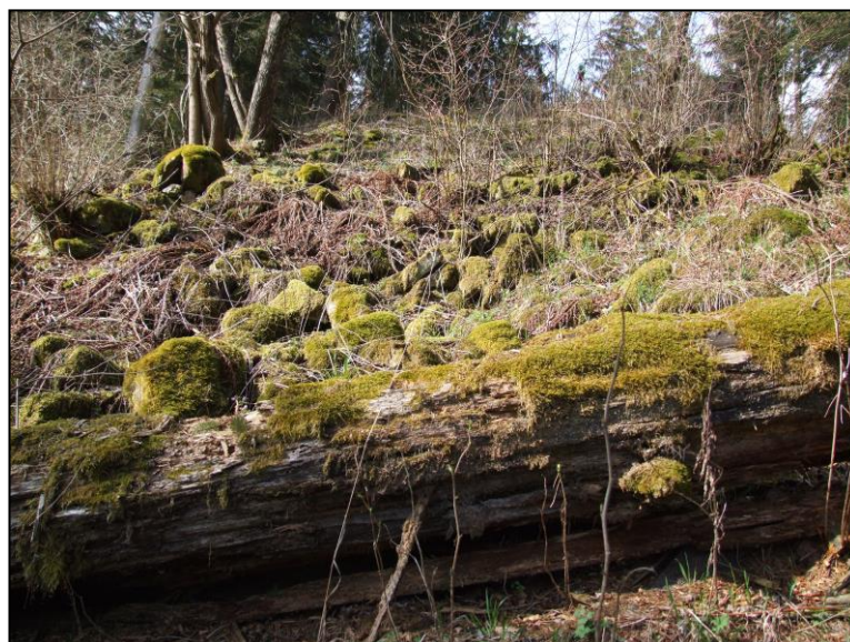
Obr. 36: Hausberk hrad. Kamenná destrukce v jihovýchodní části hradního svahu. Foto A. Pojarová a J. Hložek.
