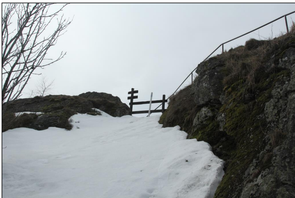
Obr. 5: Ostrý hrad. Severní vyústění šijového příkopu. Foto A. Pojarová.
