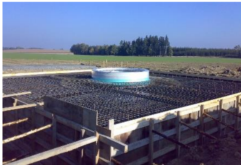
Obr. č. 7 Základní fundament s ocelovými výztužemi, připravený na zalití betonem [20]
