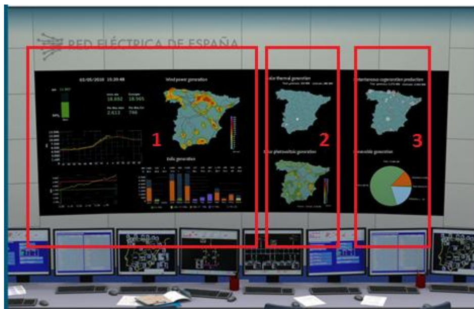
Obr. č. 35 Hlavní panel v řídicí místnosti CECRE [8]
