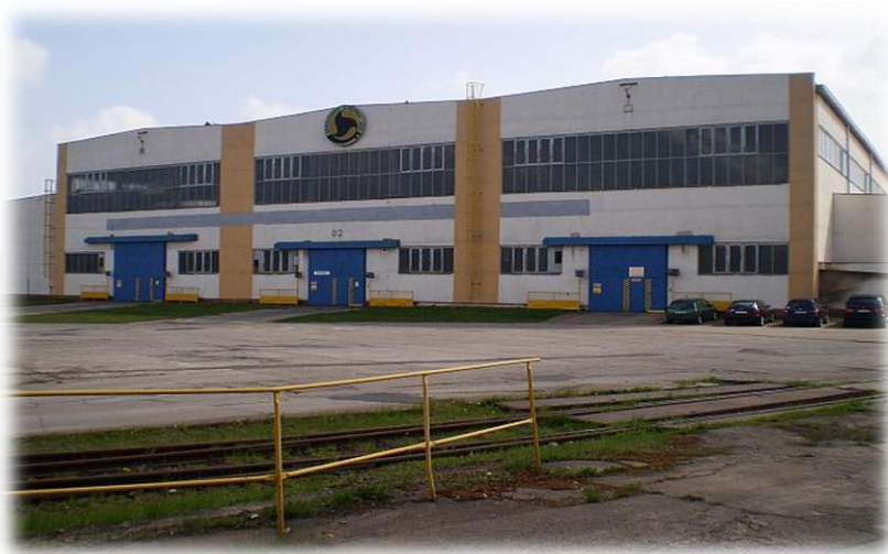
Obr. č. 3: Areál společnosti - hlavní hala
