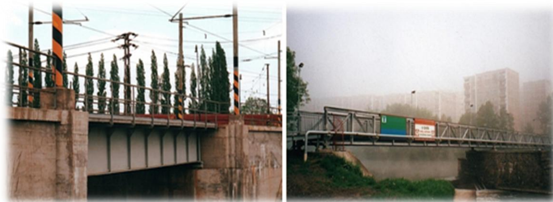
Obr. č. 9: Železniční most a lávka pro pěší a cykloturistiku
