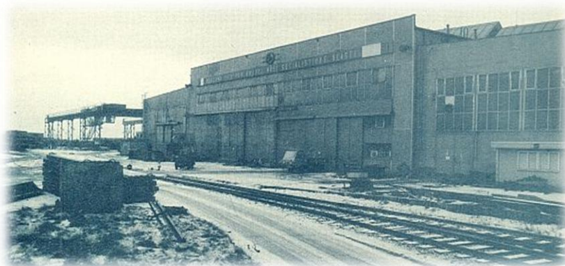
Obr. č. 2: Pohled na závod Cheb - hlavní hala
