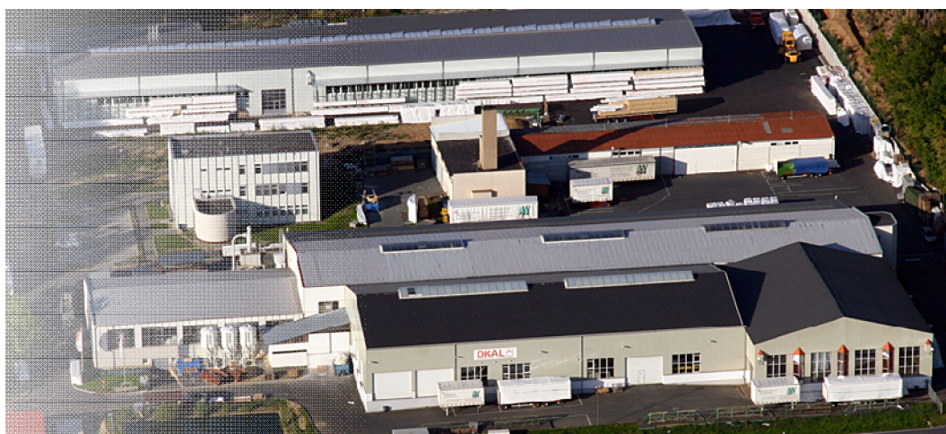
Obr. č. 8: Areál společnosti DFH Haus CZ s.r.o v Žákavě
