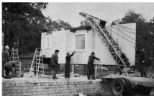
Obr. č. 6, 7: První montovaná dřevostavba
