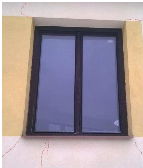
Obrázek 27: Obrázek správného umístění výztuže v místě otvoru a znárodnění prasklin při jejich absenci
