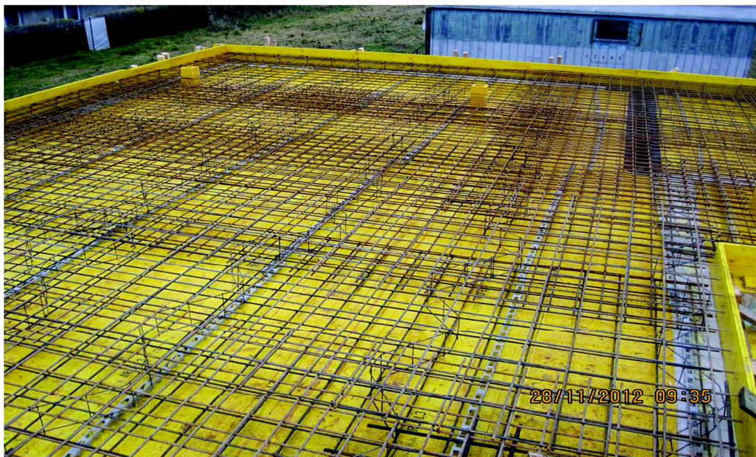
Obrázek 17: Monolitický deskový strop
