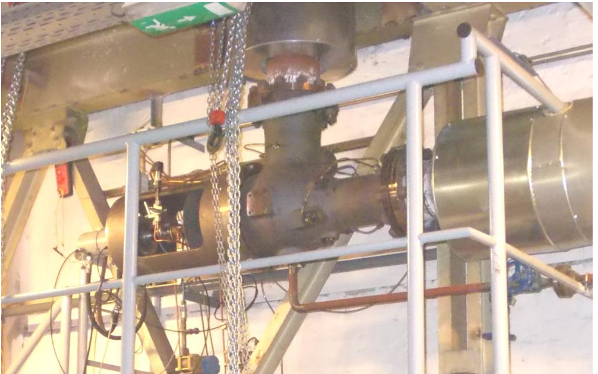
obr. 3 - Parní ventil Škoda s odlehčením [3]
