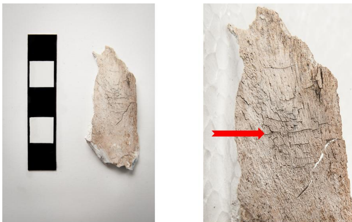
Obr. 19 a 20. Síťová struktura prasklin. (celkový pohled). Síťová struktura prasklin (detail)
