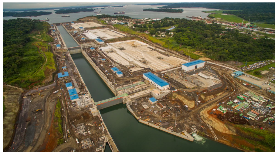
Příloha č. 33 – Výstavba nových Gatunských zdymadel (2013, 2014 a 2015)
